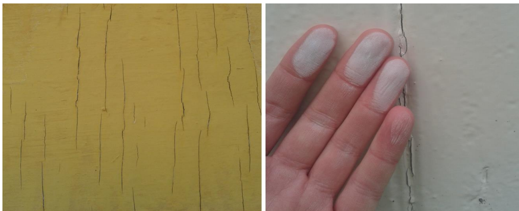
Kuva 47. Vasemman puoleisessa kuvassa öljymaaleille tyypillistä puunsyiden vastakkaista halkeilua, joka johtuu alla olevan puun kosteuselämisestä. (Jani Wilhola 2015.)
