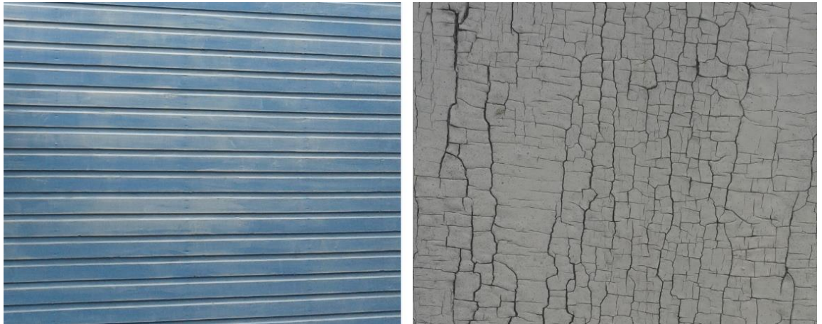
Kuva 45. Vasemman puoleisessa kuvassa öljymaalille tyypillistä värisävyjen haalistumista, mikä on voimakkainta tummilla värisävyillä. Haalistumista esiintyy usein voimakkaimmin eteläseinällä. (Jani Wilhola 2015.)
