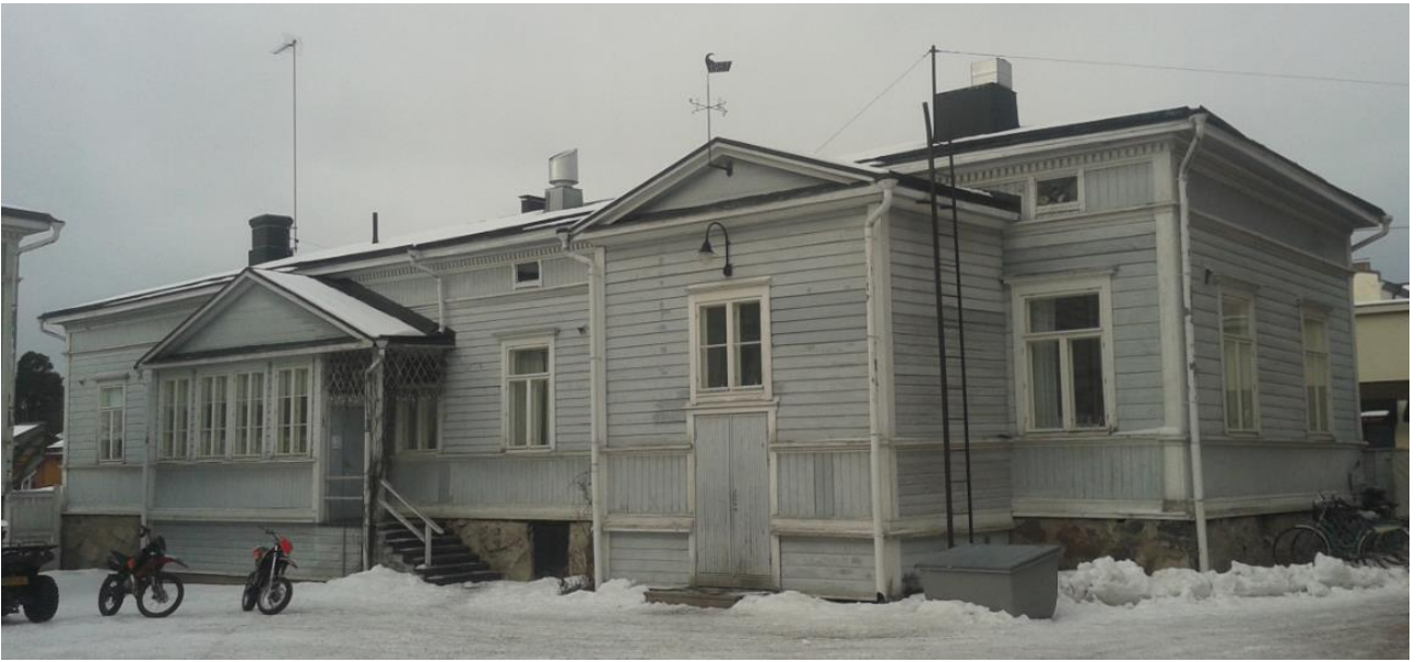
Julkisivu kaakkoon. Rakennusten metallipinnoista maalataan talotikkaat ja syöksytorvet.
