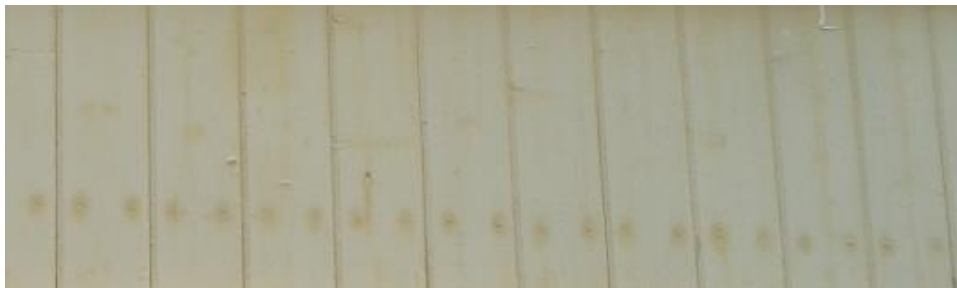
Kuva 38. Auringon säteilylle alttiit tumman keltaiset värit haalistuvat voimakkaasti. Seinä on maalattu alkydiöljymaalilla. (Jani Wilhola 2015.)
