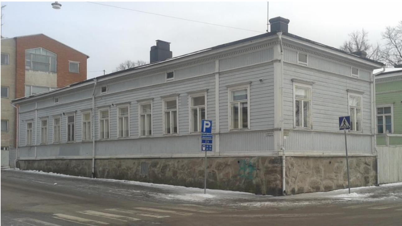
Julkisivu lounaaseen, pääty luoteeseen.
