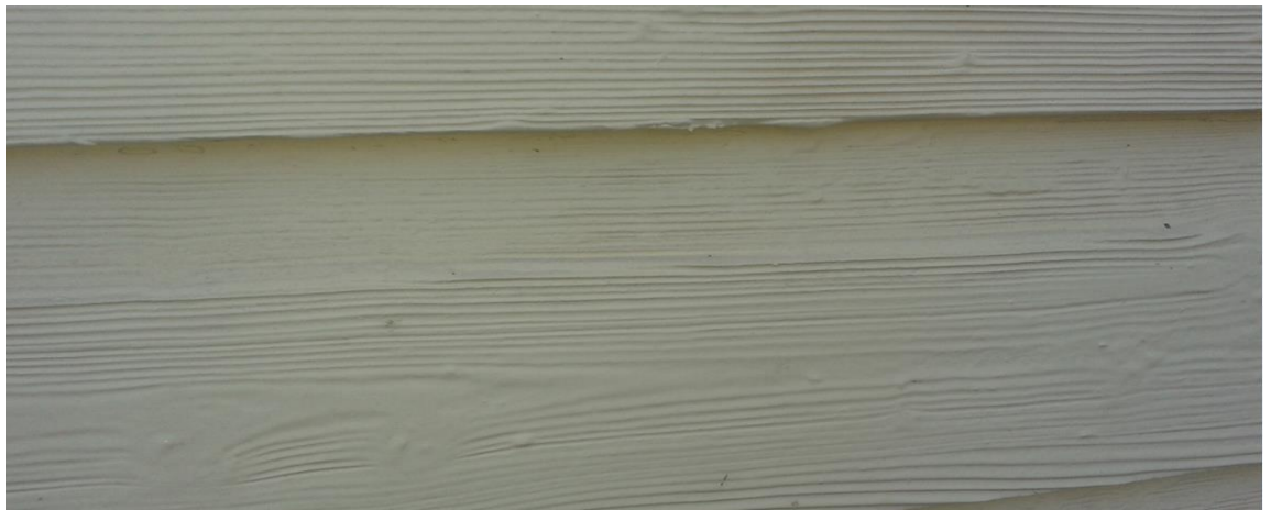
Kuva 41. Hiekkapuhalluksen jäljiltä puun pinnassa on usein syviä uria. Pehmeä kevätpuu on irronnut puhalluksen voimasta, ainoastaan kovempi kesäpuu on jäänyt jäljelle. (Jani Wilhola 2015.)
