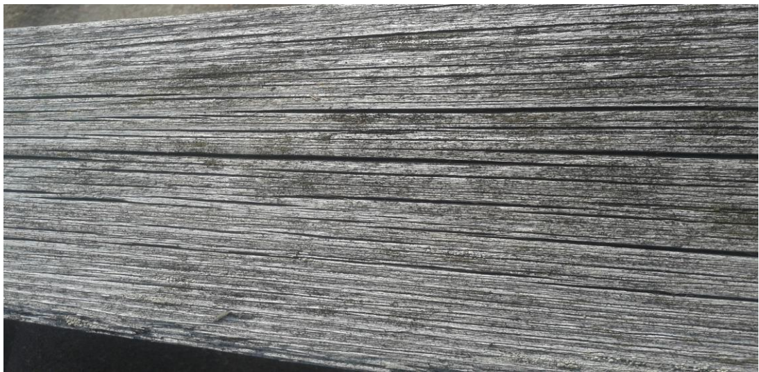
Kuva 1. Nopeat kosteusvaihtelut aiheuttavat käsittelemättömässä puussa kuivumishalkeilua. Kuvassa oleva lauta sijaitsee vanhan rakennuksen vesikatolla kattosiltana. Säälle täysin alttiissa laudassa ei ole kuitenkaan merkkejä lahovaurioista. (Jani Wilhola 2015.)
