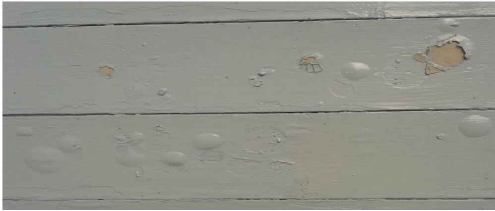
Kuva 29. Aurinkokuplia muodostuu herkemmin eteläiselle seinälle, joka altistuu voimakkaimmalla auringonlämpösäteilylle. (Jani Wilhola 2015.)
