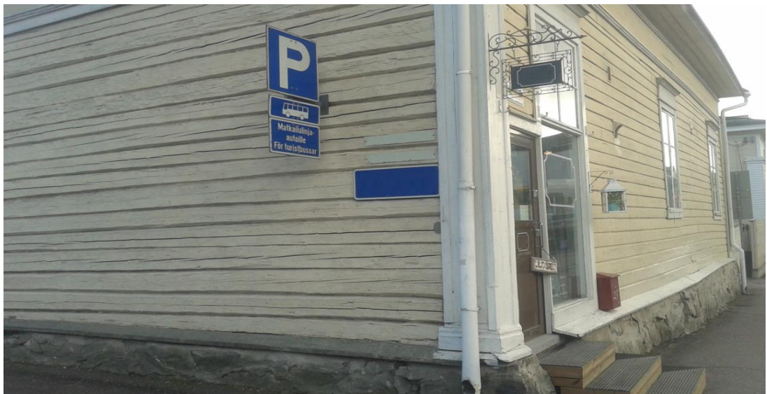
Kuva 6. Pohjoisjulkisivu altistuu muita seiniä verrattuna vähäisemmälle säärasitukselle, minkä seurauksena uhrikerroksena toimiva julkisivulaudoitus on voitu jättää asentamatta. (Jani Wilhola 2015.)
