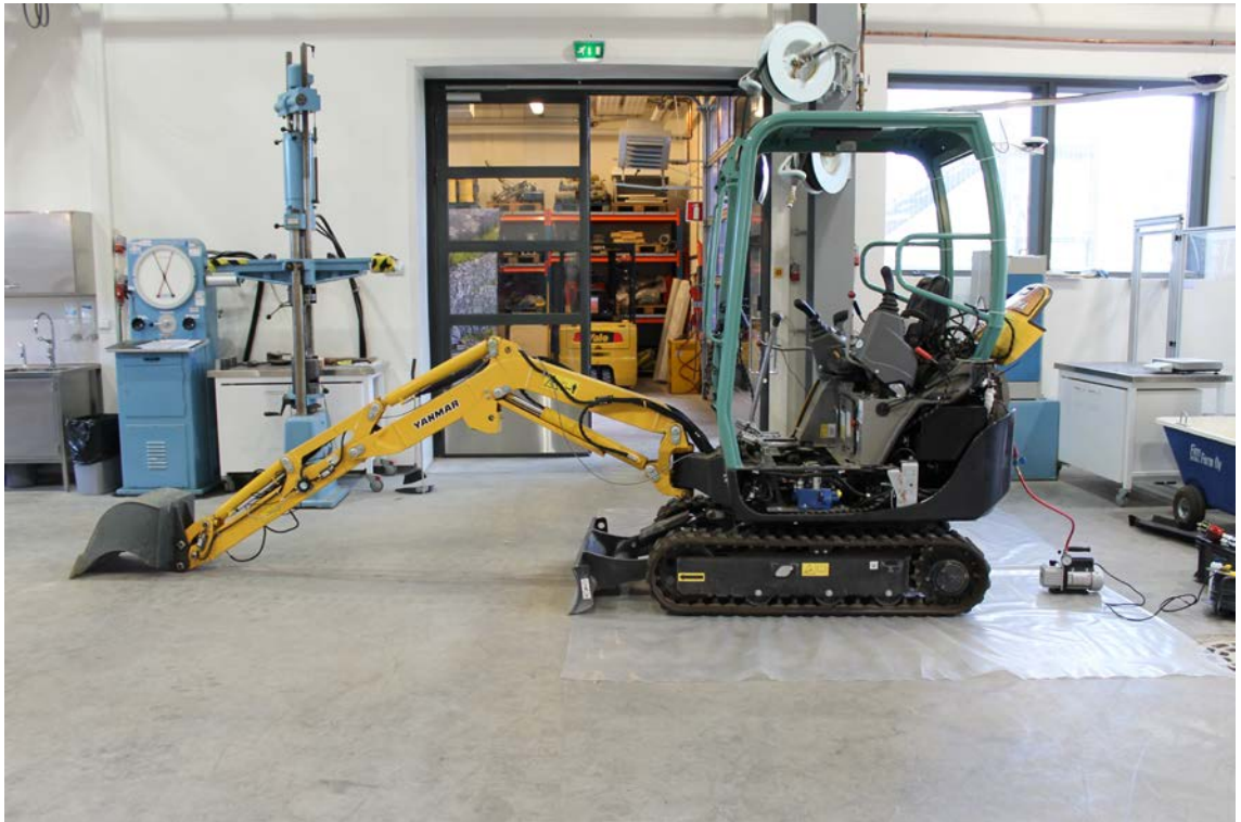
KUVA 8. Asennuksen yleiskuva (Kuva: Ville Junno 2015)
