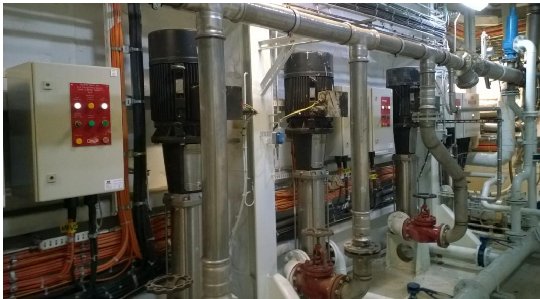
Kuva 12. Sprinklerijärjestelmän pumput
