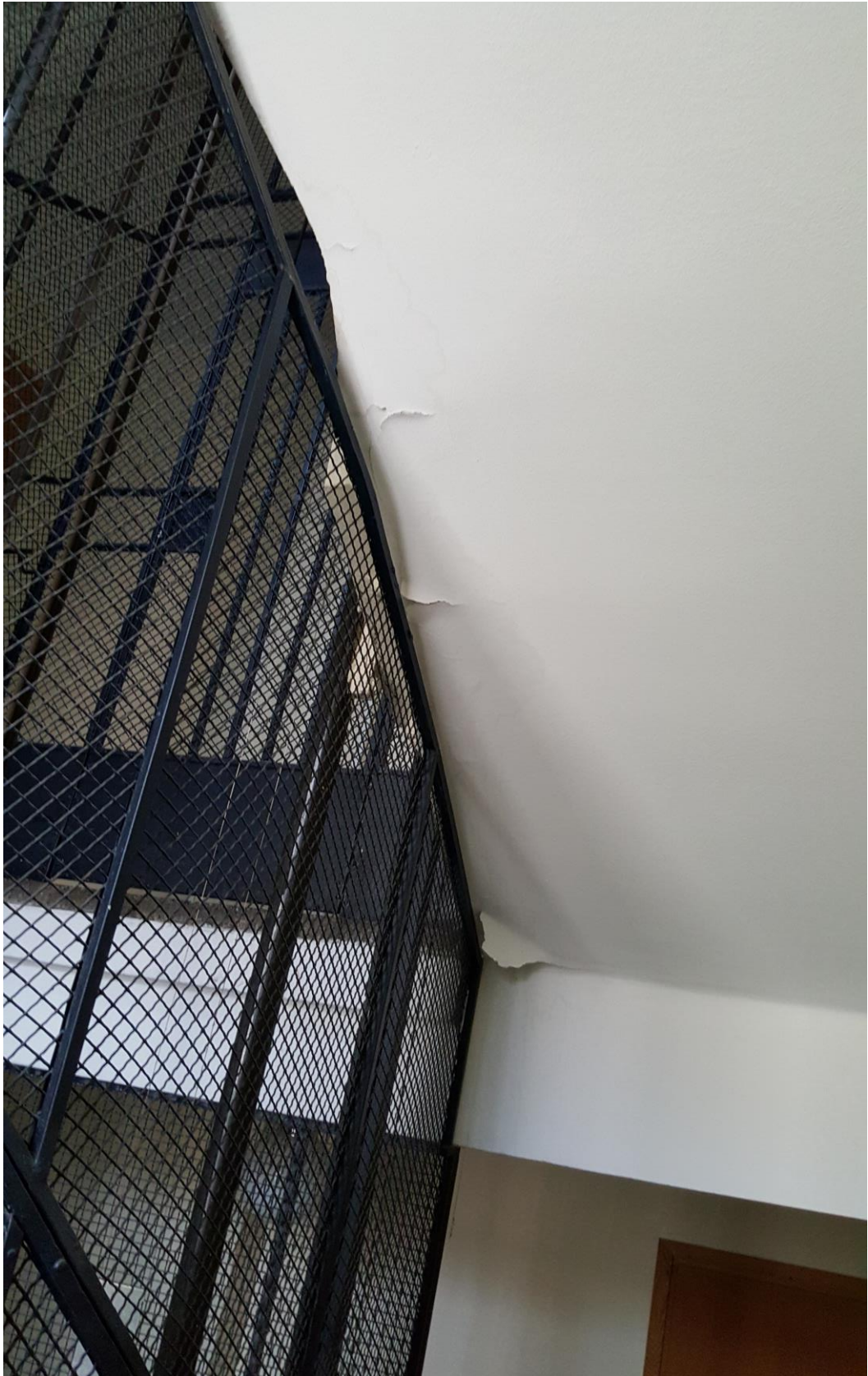
Kuva 5. Porrassyöksystä maali lohkeilee irti.
