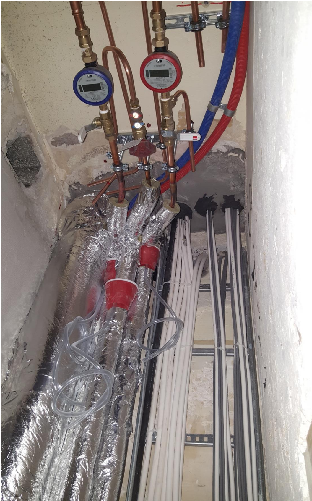
Kuva 2. Avonainen nousuhormilinja ja samassa yhteydessä myös sähkönousulinja.
