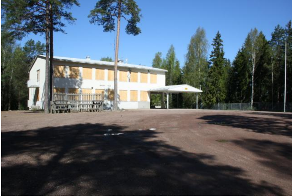
Kuva 21. Päiväkodin viereisen entisen koulurakennuksen piha.
