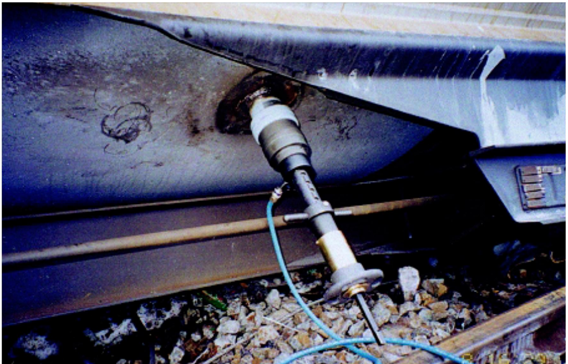
Kuva 1. Yhteysputki hitsattu ja porauslaite paikoillaan. Säiliön paksuus 12,2 mm (NOU 2001, 41, 66).
