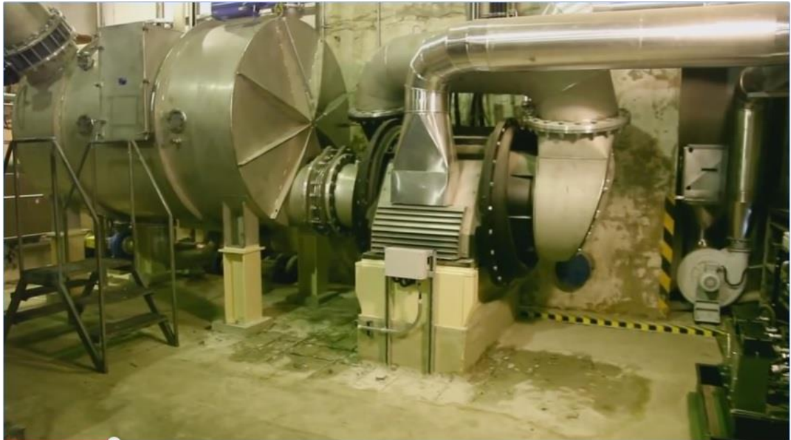
Kuva 2. Kuvassa edessä EP-500-700-S turbo. Kuvassa vasemmalla on vedenerotin (Runtech 2015)
