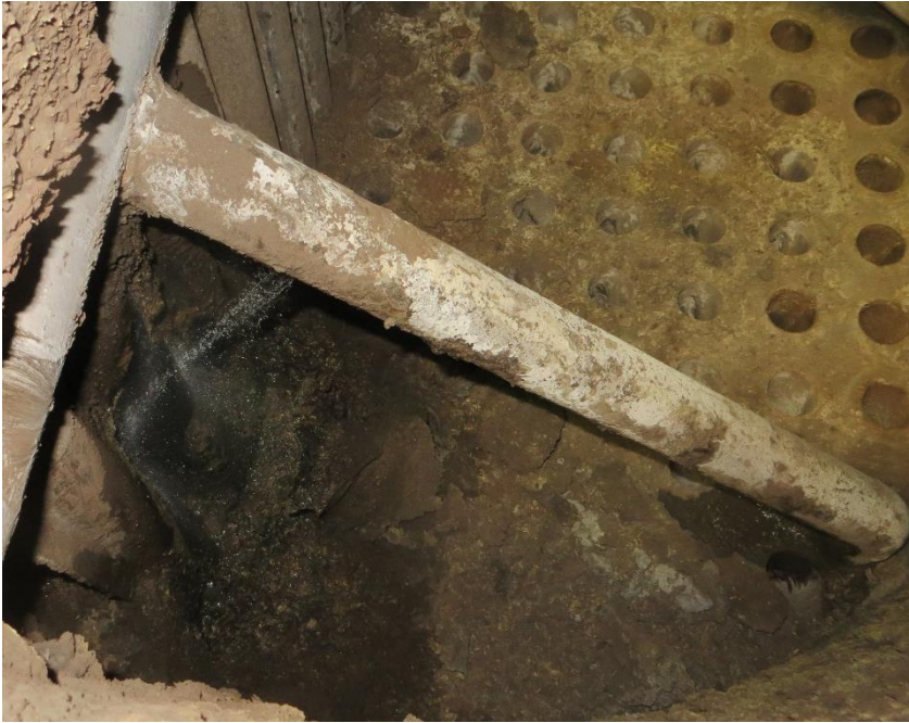
KUVA 4. Putkivaurio konvektio-osan alussa (17)
