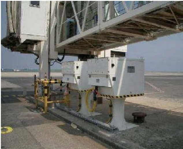
Figur 7. Två stycken motordrivna "coil"-vindor under en passagerarbrygga.
