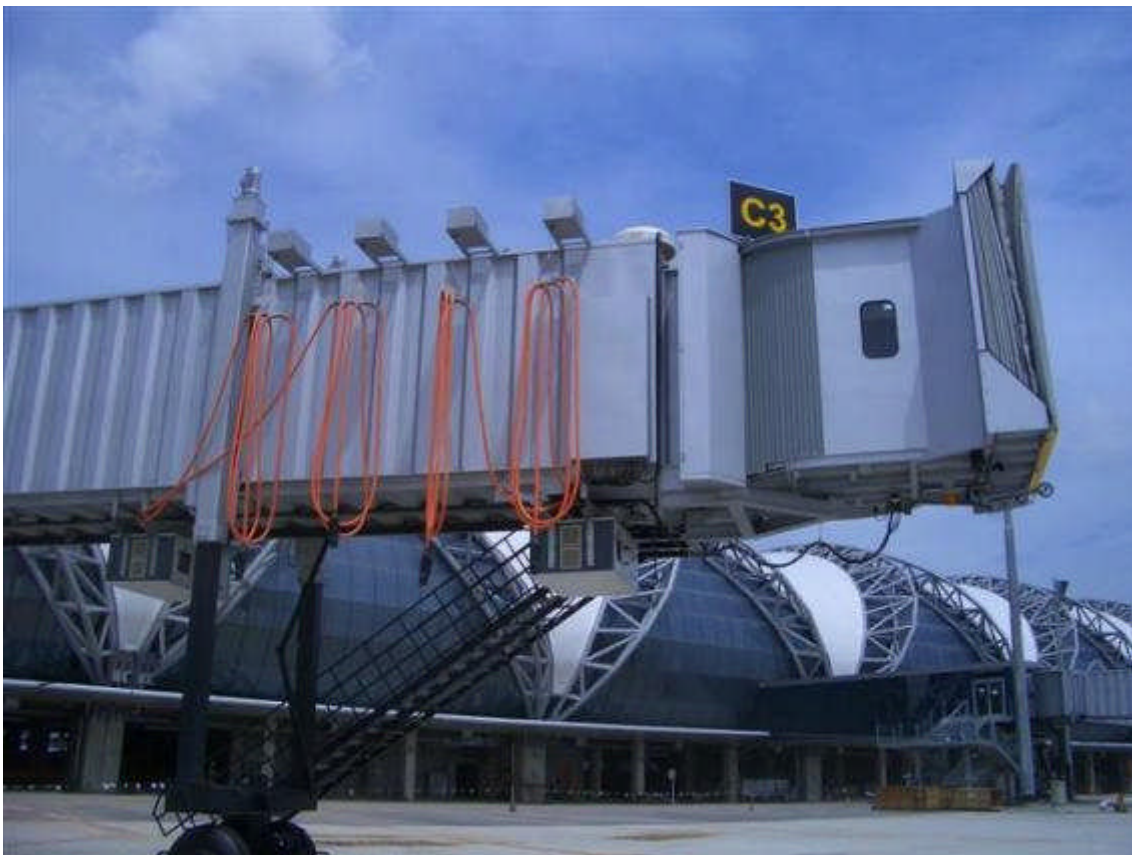
Figur 4. Fyra stycken "Hoist"-system installerade vid en passagerarbrygga.
