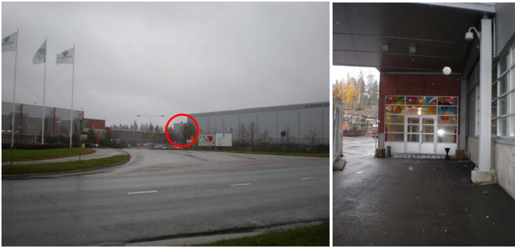
Kuva 2. Vasemmassa kuvassa ympyröity, missä uudet tilat sijaitsevat Sinebryhoffin tehtaalla. Oikeassa kuvassa rakennuksen alaovi, josta uusiin tiloihin kuljetaan.
