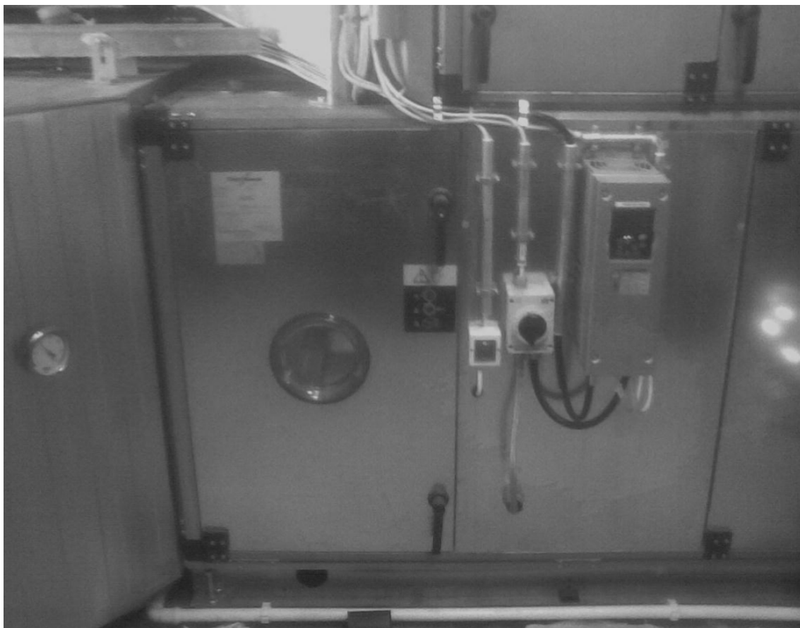
Kuva 1. Uudet taajuusmuuttaja ja turvakytkin asennukset
