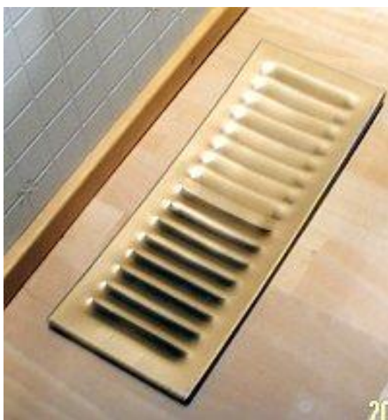
Kuvio 31 Lattialle asennettu säleikkö
