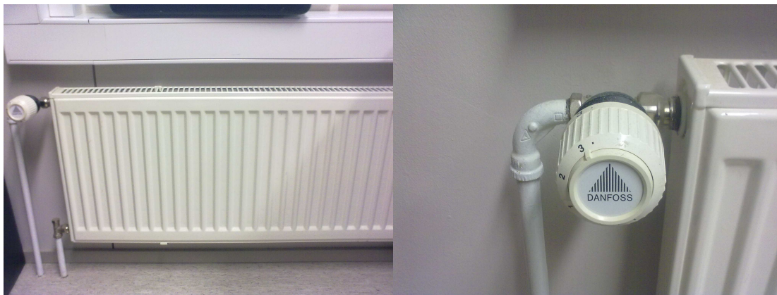
Kuvio 8. Vesikiertoinen patteri ja patteritermostaatti (Kuva: Niko Puranen 2011)
