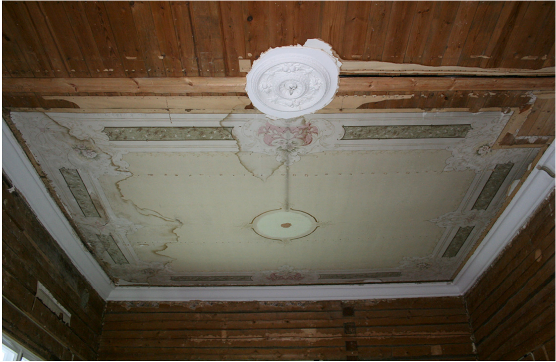
Kuva 12. Yleiskuva salin katosta koillisreunalta kuvattuna. Väliseinä on alun perin kulkenut kuvan yläosassa näkyvän rosetin kohdalta. (Junnola, 2011.)
