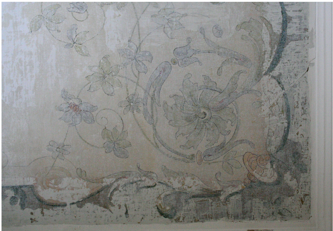
Kuva 6. Huone 22, eli yläkerran vierashuone. Juuttikankaalle maalattu naturalistinen koristemaalaus. Tyylillisesti se sopii hyvin vuosisadan vaihteen muotiin. (Junnola, 2011.)
