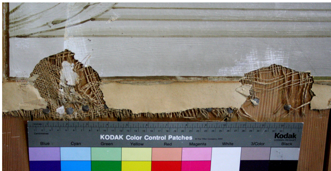
Kuva 1. Katon koillisreuna. Juuttikankaasa olevat reiät ennen toimenpiteitä. (Junnola, 2011.)
