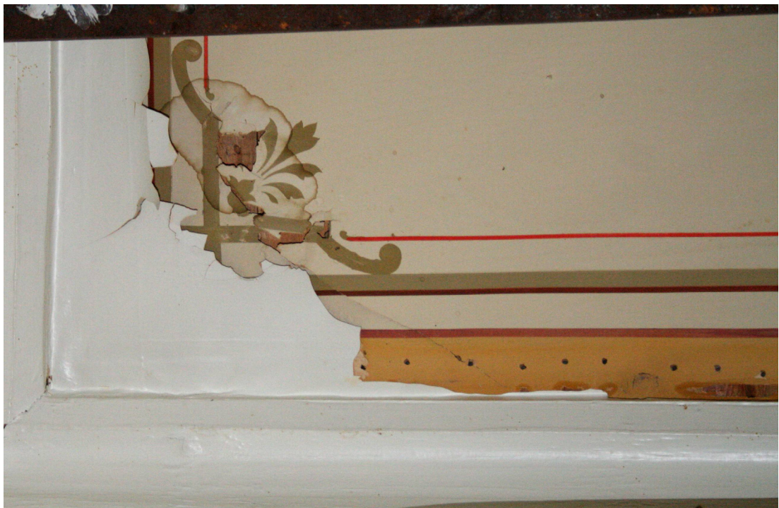
Kuva 2. Huone 19, eli keittiö. Tilassa on säilynyt fragmentteja pinkohville maalatusta, melko yksinkertaisesta sabluunamaalauksesta. (Junnola, 2011.)
