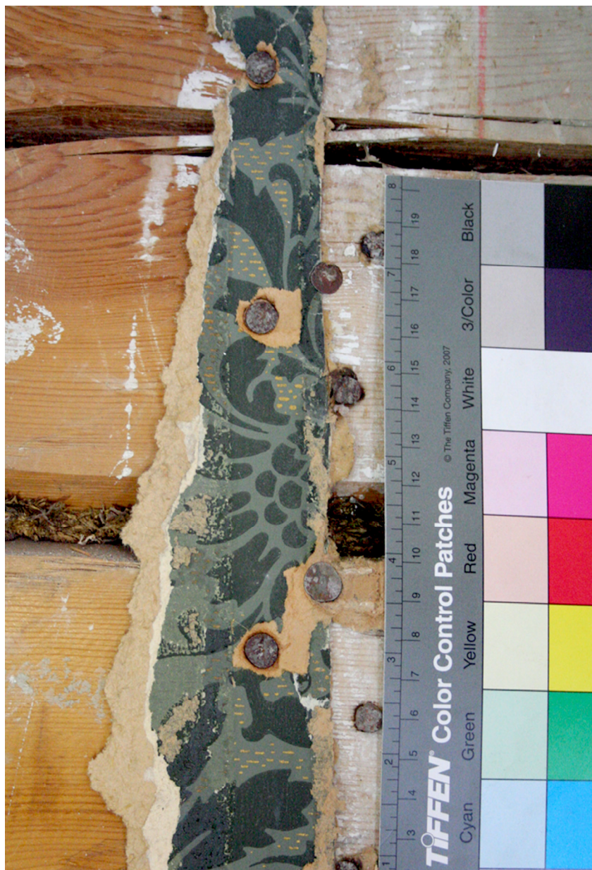
Kuva 1. Fragmentti salin ensimmäisestä tapettikerroksesta. Kuvassa näkyy tapetin taustalla oleva kulanvärinen rasterointi. (Junnola, 2011.)
