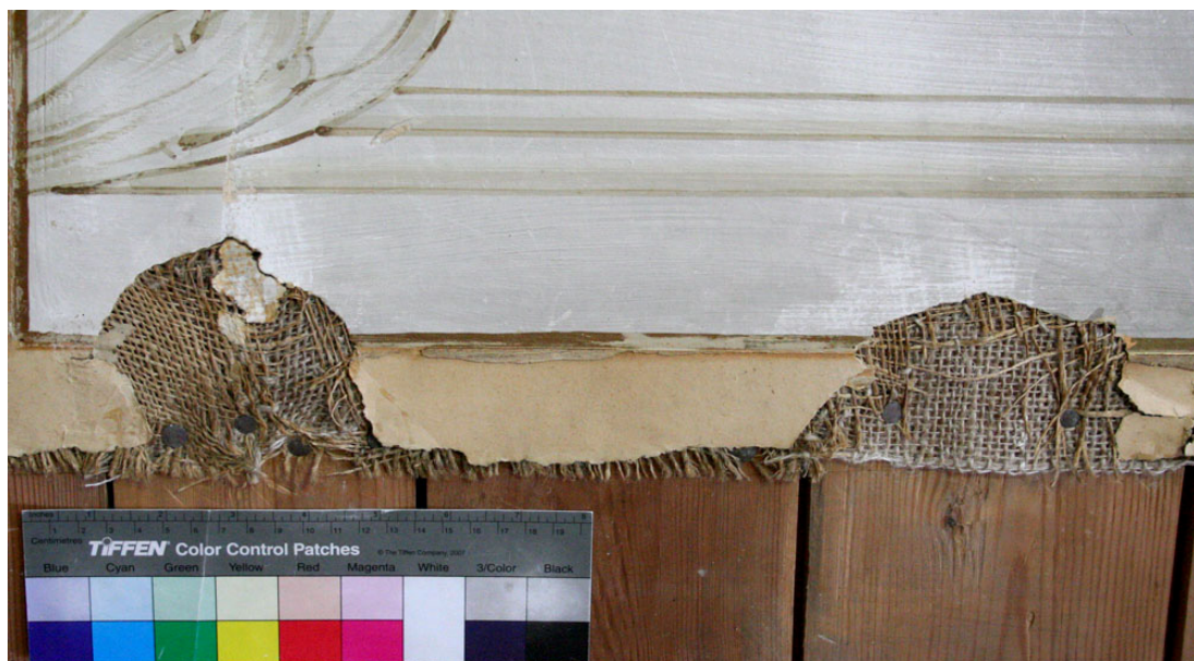
Kuva 2. Reiät taustoitettiin juuttikankaalla, joka kiinnitettiin ompelemalla ja injektoimalla akryylidis-persioliimaa. (Junnola, 2011.)
