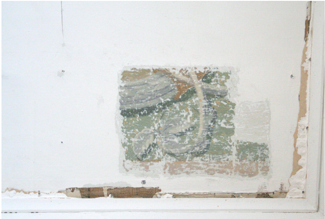
Kuva 7. Huone 23, eli yläkerran toinen vierashuone. Koristemaalaukset on maalattu paperoidulle juuttikankaalle, mutta esiinotto on niin pieni, että kuviointia ei voida luotettavasti päätellä. Maalaus ei ulotu holkkalistoja alle, vaan sen reunat on todennäköisesti huoliteltu erillisellä listalla. (Junnola, 2011.)
