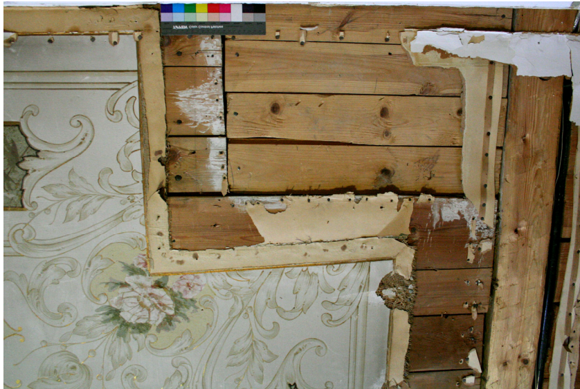
Kuva 13. Katon pohjoiskulma, jossa on alun perin ollut uuni. Koristemaalauksen päätyttyä paperointi jatkuu vielä käsittelemättömänä muutaman senttimetrin. (Junnola, 2011.)
