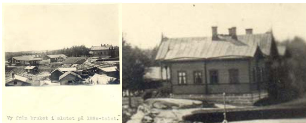
Kuva 7. Vanha valokuva tehdasalueesta ja suurennos kuvassa oikealla olevasta Patruunan Pytingistä; alkuperäisen kuvan alla on kuvateksti "Vy från bruket i slutet på 1800-talet". Kuva on otettu ennen Pytingin tornimaisen laajennusosan rakentamista 1898. Oikeanpuoleisessa kuvassa näkyy hyvin katon aumattu pääty ja koillispäädyn vasemmassa reunassa oleva valeikkuna. (Verlan tehdasmuseon arkisto)
