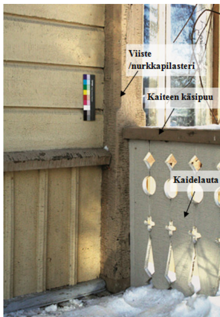
Kuva 4. Yksityiskohta kaakkoisjulkisivulta, avoverannalta. Kuvan oikealla puolella näkyy avoverannan kaiderakennetta ja vasemmalla vaakalaudoitettua seinäpaneelia, rintalistaa ja pystyrimalaudoitettua rintapaneelia. (Mäenpää 2011)
