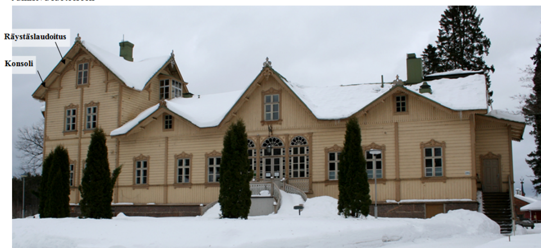
Kuva 2. Julkisivun yläosan rakenteiden nimityksiä luoteisjulkisivulla. (Verlan tehdasmuseo 2010)
