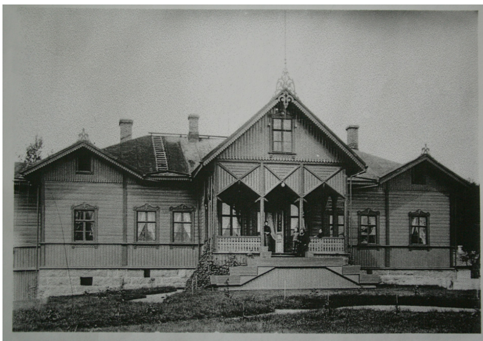
Kuva 2. Pytingin kaakkoisjulkisivu ennen vuotta 1898. Kuvassa näkyy hyvin rakennuksen aumakatto, jonka katemateriaalina voisi kuvan perusteella olla huopa. Avoverannalla on ollut kuvassa näkyvä helmalaudoitus, joka on myöhemmin poistettu (Museoviraston Arkisto)
