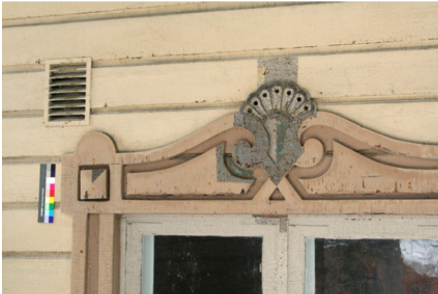
Kuva 6. Sinisen värikerroksen esiinnotto avoverannan ikkunan vuorilaudoituksen yläosassa. Seinävärinä on siniharmaa, listaväri tummempi harmaansininen ja korosteväreinä on vihreä ja tummansininen. Esiinnotto on tehty aikaisemmissa tutkimuksissa. (Mäenpää 2011)
