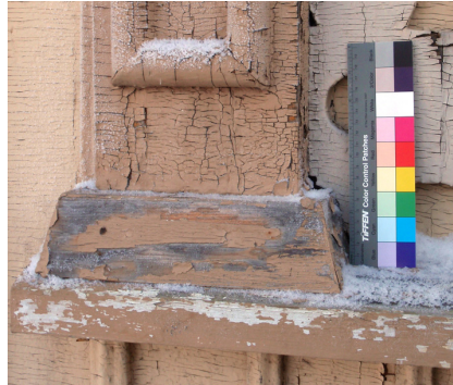
Uusittu pilasterin jalusta sisäänkäynnin oikealla puolella.
