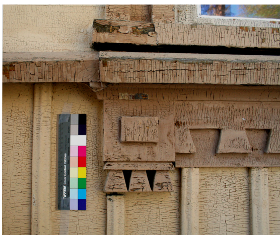
Yksityiskohta oven alaosasta.
