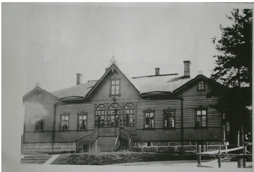
Kuva 1. Pytingin luoteisjulkisivu ennen vuotta 1898.(Kuvaaja tuntematon)
