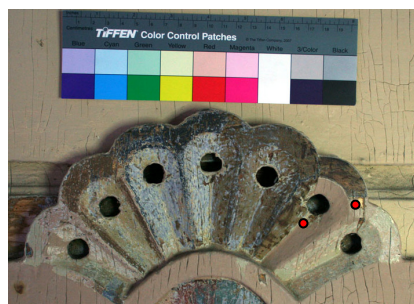
Ikkunan vuorilaudoitus, palmetin keskiosa (PyIVu13_4x)
