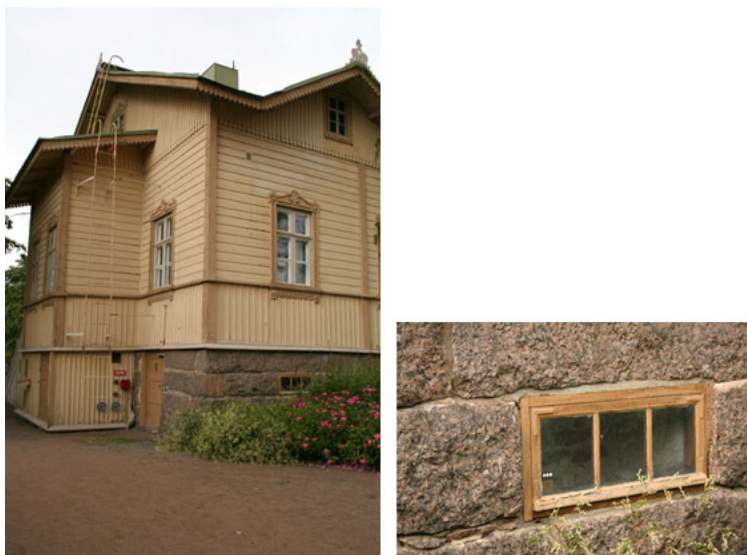
Kuva 12. Pytingin etelänurkka puiston puolelta ja kivijalassa oleva keskuslämmityshuoneen eteisen ikkuna. Kolmiruutuinen ikkuna on asennettu todennäköisesti 1940-luvun vaihteen peruskorjauksessa ja muurattu sisäpuolelta umpeen 1960-luvun lopussa. (Mäenpää 2010)
