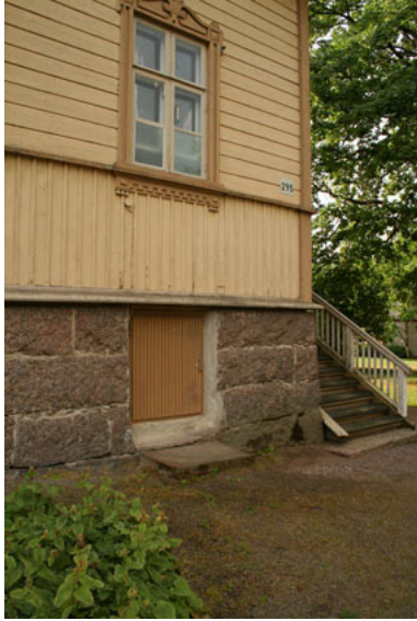
Kuva 13. Luoteisjulkisivun kivijalkaan on asennettu kellarin ikkunan kohdalle 1970-luvun vaihteen peruskorjauksessa kylmiöön vievä ovi. (Mäenpää 2010.)
