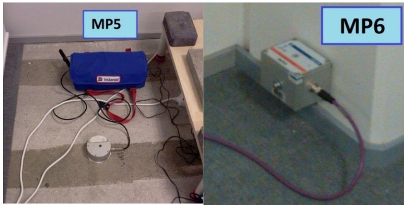
KUVA 27. Maanvaraiseen betonilattiaan asennettu InstanTel MiniMate tärinämittari MP5, sekä louhintaa lähinnä olevaan betonipilariin asennettu Sigicom Infra tärinäanturi MP6.
