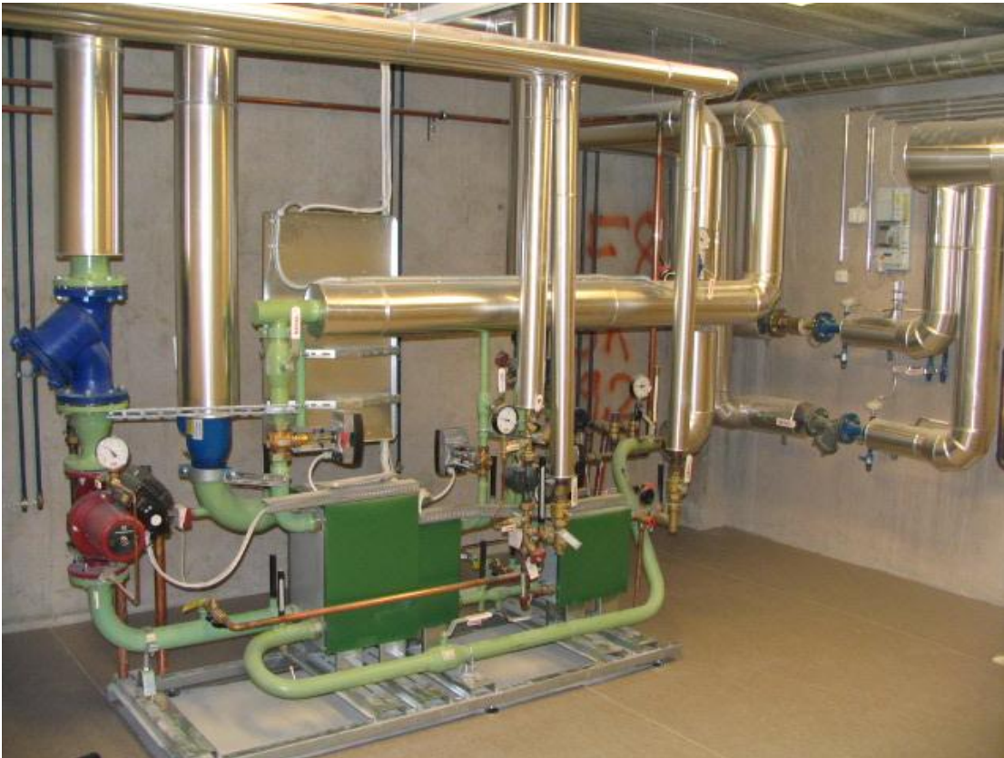
Kuva 5. Asiakkaan lämmönjakokeskus
