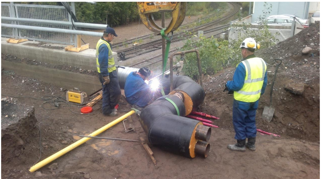
Kuva 4. Kiinnivaahdotetun kaukolämpöjohdon liittäminen Varkaudessa
