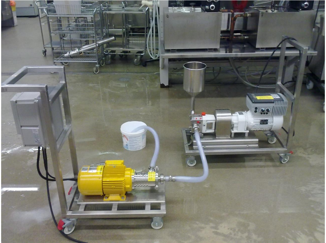
Kuva 6. Massan muokkaukseen käytetty laitteisto. Oikealla pumppu, jossa syöttösuppilo ja vasemmalla YTRON-Z-homogenisaattori.
