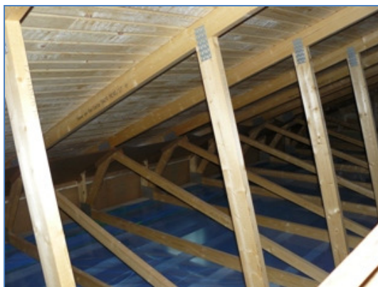
Kuva 49. NR-kattoristikot.
