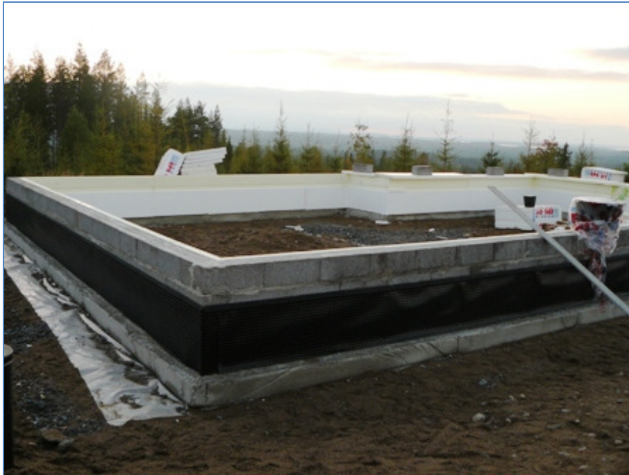
Kuva 26. Perustusmuuri veden- ja lämmöneristettynä ennen routaeristämistä ja täyttöjä.
