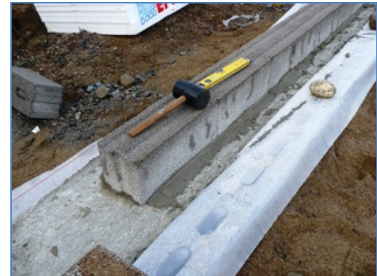
Kuva 21. Anturan päällä 1. harkkokerros.
