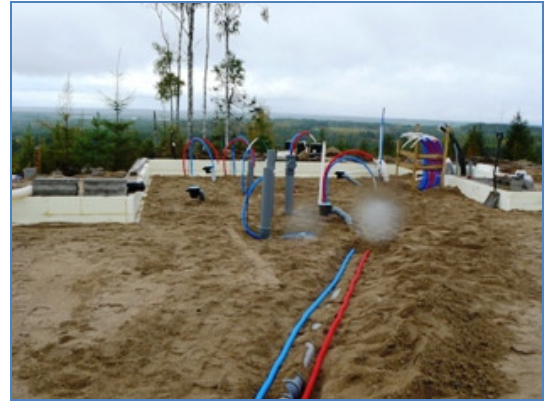
Kuva 28. Vesiputket ennen peittämistä.
