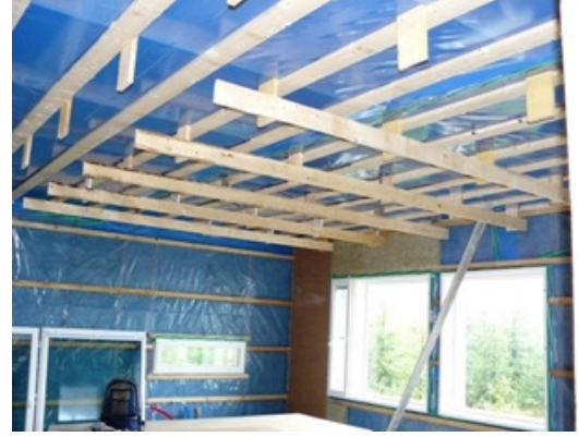
Kuva 52. Alaslaskettu laipio.
