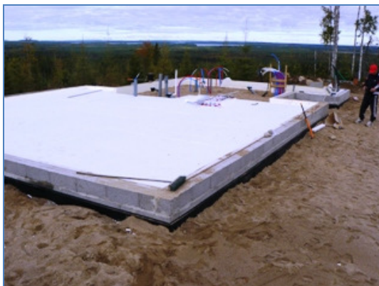
Kuva 29. Alapohjan EPS-eristäminen.
