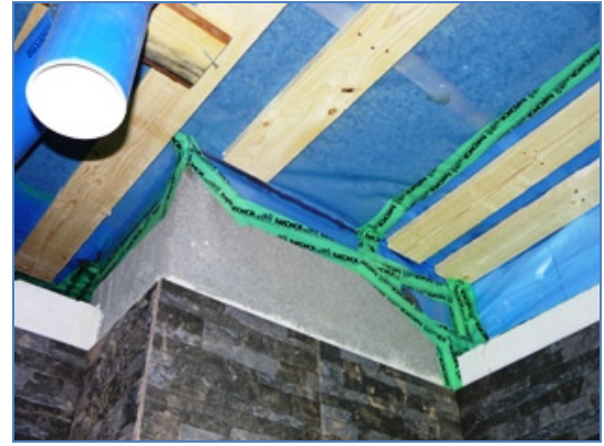
Kuva 56. Hormiston juuren tiivistys.
