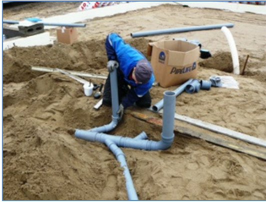
Kuva 27. Viemäriputkien asennus.
