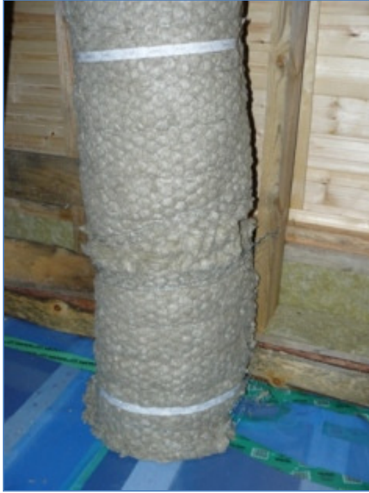
Kuva 59. Liesituulettimen putki.
