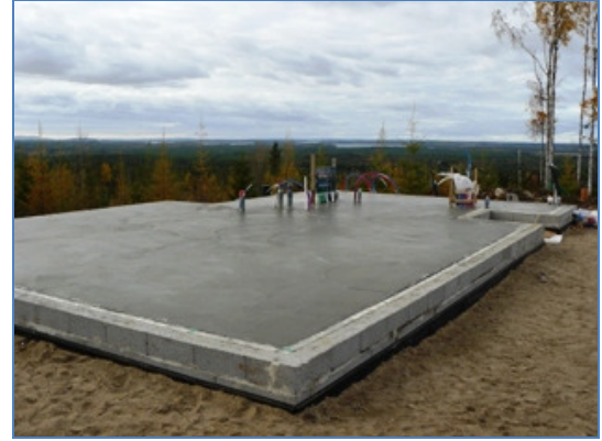
Kuva 32. Teräsbetonilaatta valettuna.
