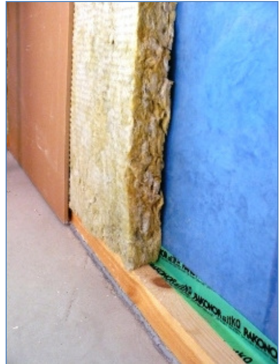
Kuva 46. Ulkoseinän ehyt tiivissulku.
