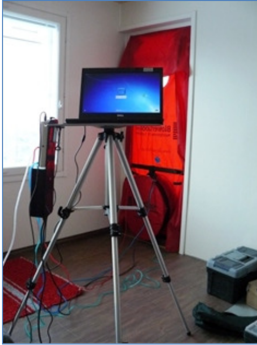
Kuva 74. Ilmatiiveysmittauksen laitteet ja kalusto.
