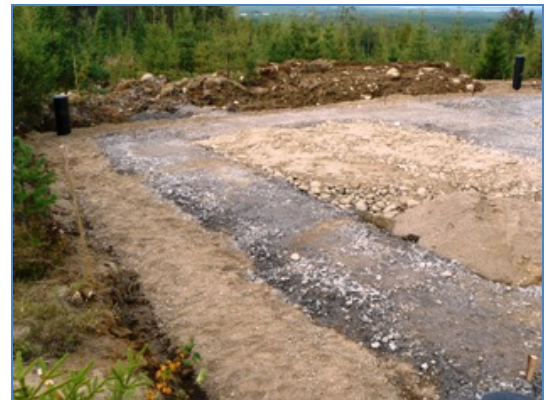
Kuva 15. Anturan alusta tiivistettynä.
