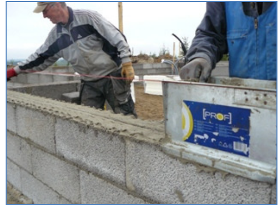
Kuva 23. Laastin levitys kelkalla.
