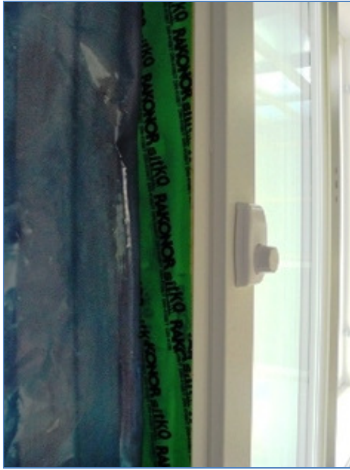
Kuva 65. Tiivis sauma ulkoseinässä.
