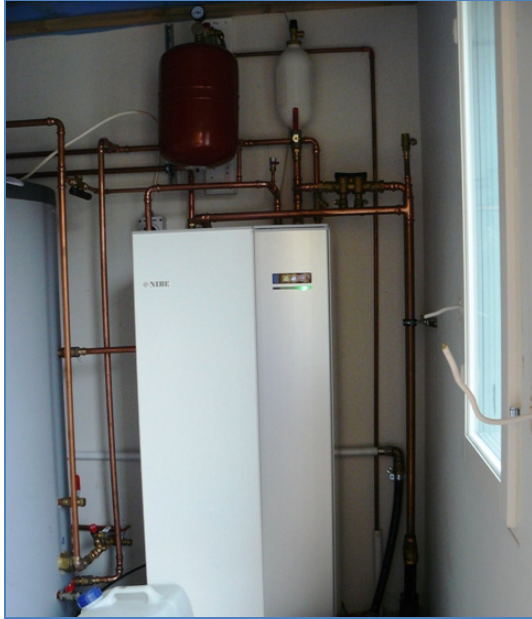
Kuva 11. Maalämpöpumppu asennettuna.
