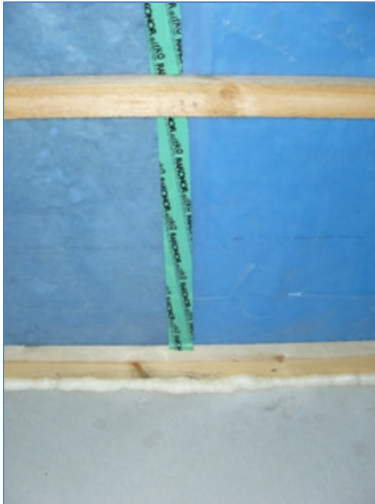
Kuva 45. PU-eriste lattian rajassa.
