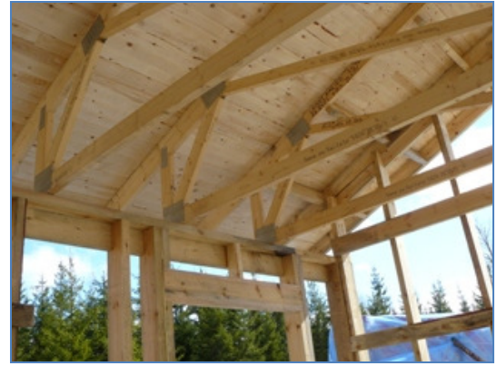
Kuva 38. Ikkuna-aukon ylitypalkki.
