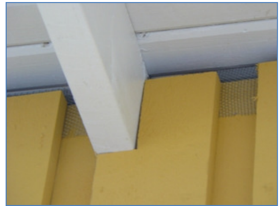
Kuva 58. Tuuletustila ja jyrksijäverkko.
