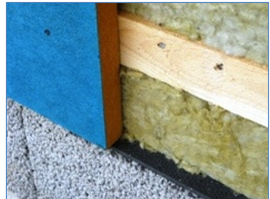
Kuva 40. Tuulensuojalevy ja eriste.
