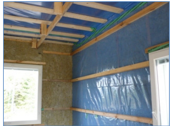
Kuva 44. Ulkoseinän vaakakoolaus ja eriste.
