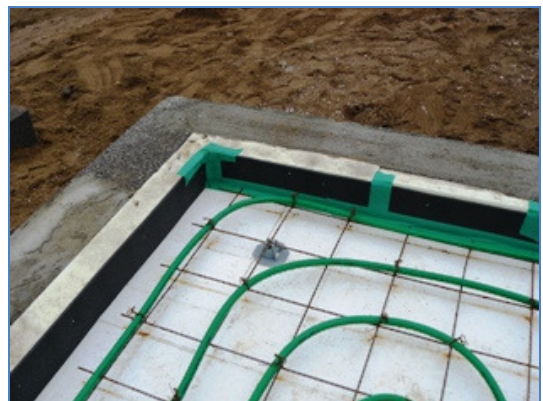
Kuva 30. Alapohja ennen laatan valua.
