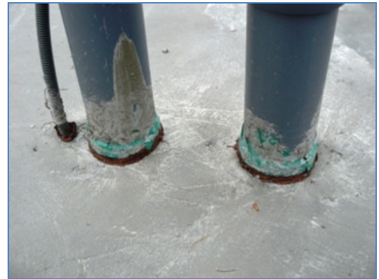
Kuva 34. Putkien juurien tiivistäminen.
