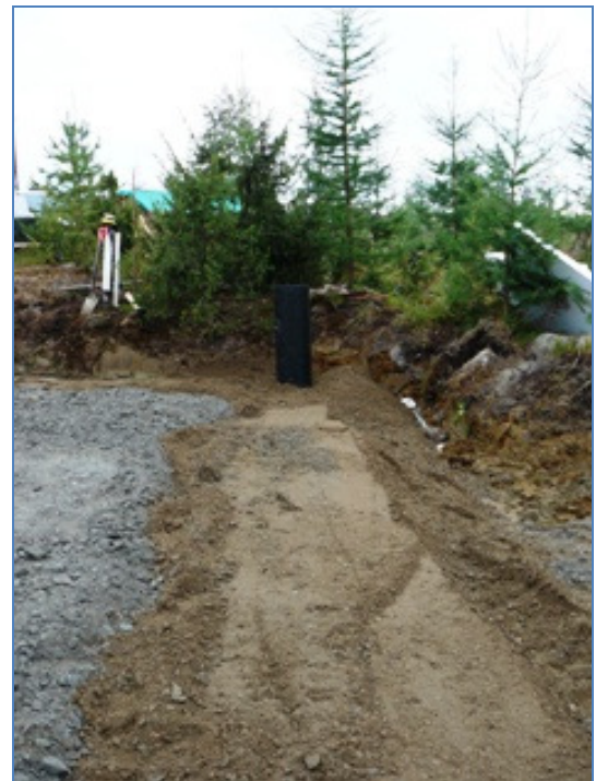
Kuva 16. Salaojaputki ja -kaivo asennettuna. Kuva 17. Salaojaputki peitettynä soralla.
