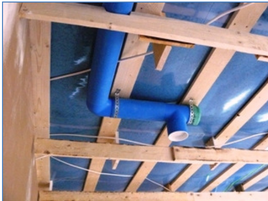
Kuva 53. Ilmastointiputkien asennus.
