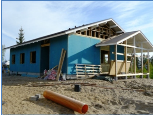
Kuva 41. Talon tuulensuojalevyvuoraus.
