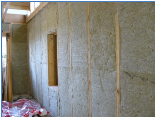
Kuva 43. Lämpöeristetty ulkoseinä.
