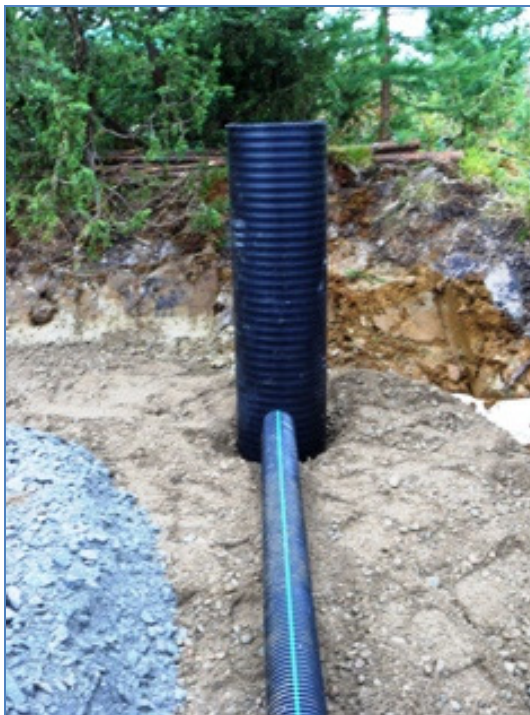
Kuva 16. Salaojaputki ja -kaivo asennettuna. Kuva 17. Salaojaputki peitettynä soralla.
