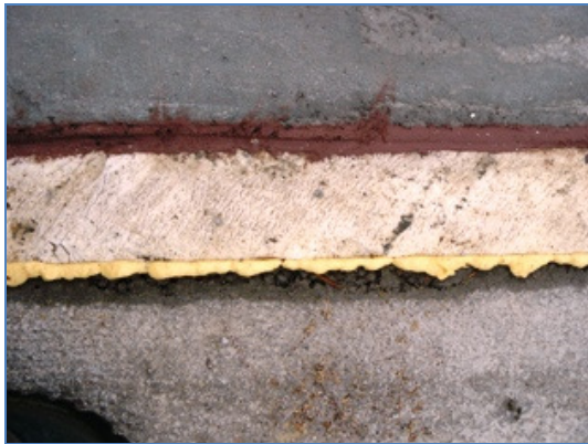
Kuva 33. Laatan reunan tiivistäminen.
