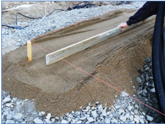
Kuva 18. Anturan alustan tasaaminen.
