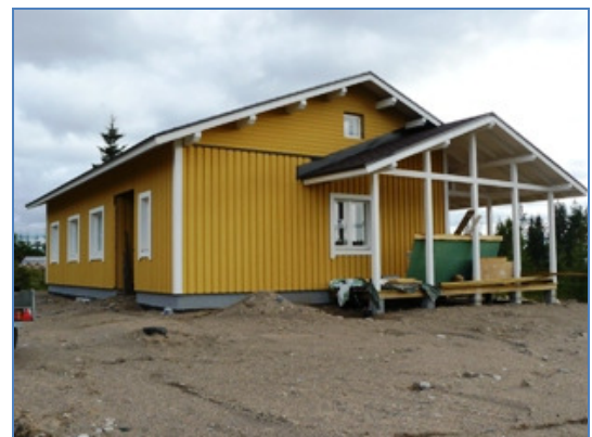
Kuva 50. Palkit kantavina rakenteina.
