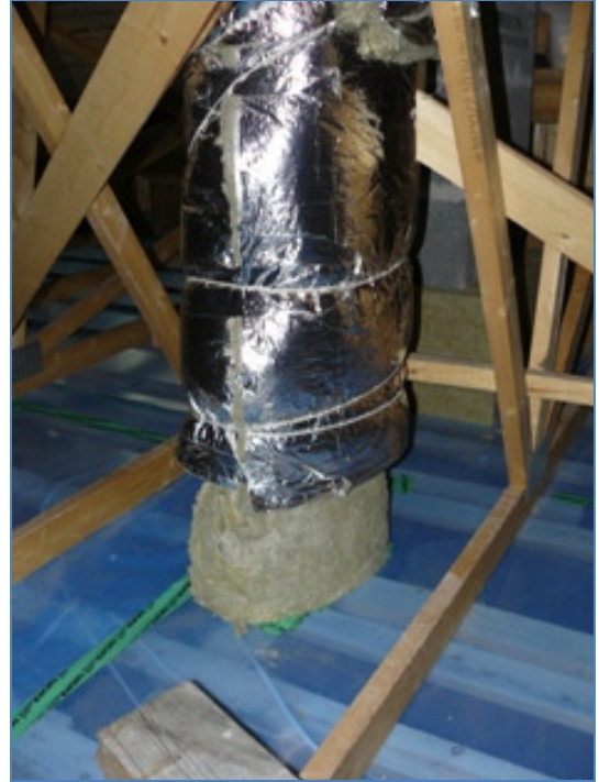
Kuva 60. Wc:n tuuletusputki.
