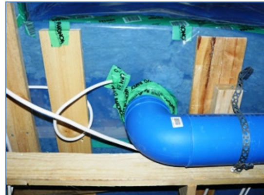
Kuva 54. Ilmastointiputken läpivienti.
