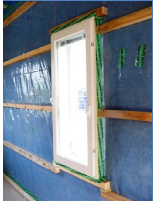
Kuva 66. Ikkuna tiivistettynä seinään.
