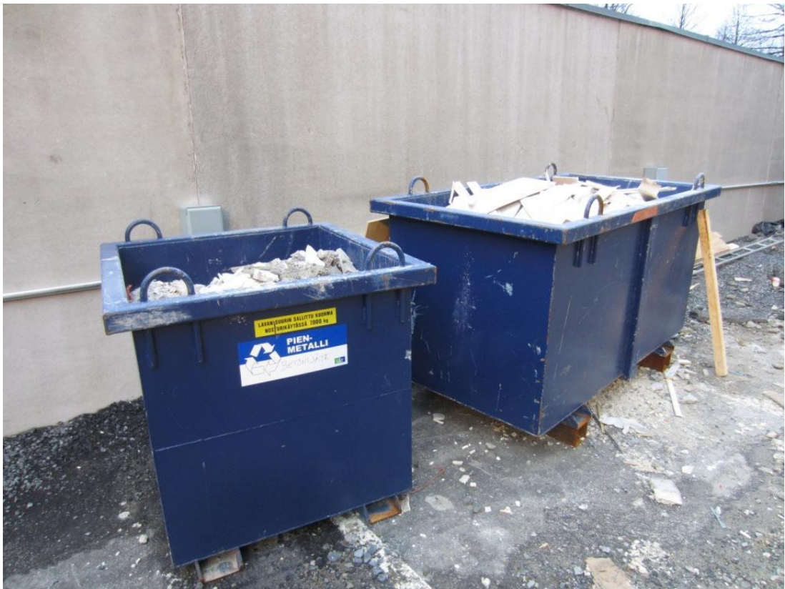
KUVA 5. Työmaan betoni- ja kipsijäteastiat. (Suoniemi 12.11.2013)
