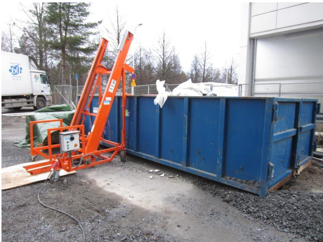
KUVA 7. Työmaan sekajätelava ja roska-astian kippauslaite (Suoniemi 12.11.2013)
