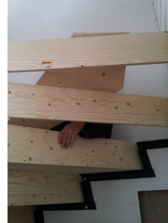
TYÖMAAKUVIA portaiden rakentamisesta. Portaiden vanerirunko päällystetään massiivisaarnella yläkerran parketin sävyyn. Kolmas askelma asettuu seinälinjaan pintakerroksen myötä.
