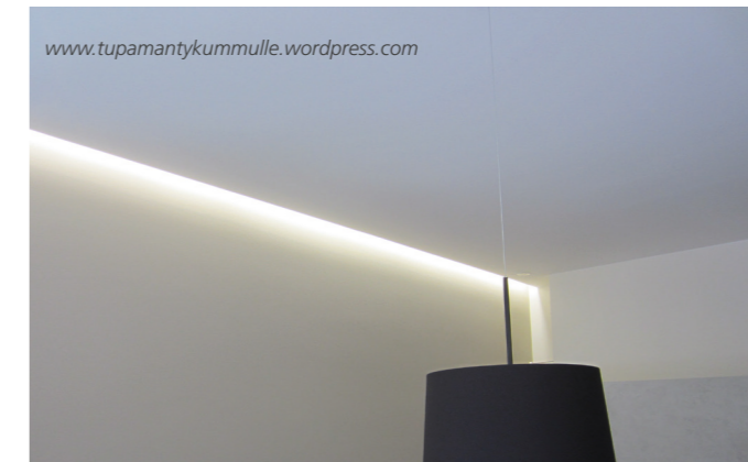
Rakenteellisesti toteutettu epäsuora valaistus valonauhoineen on toimiva ja kaunis, mutta avoimessa pohjaratkaisussa vaikeuttaa tilan mahdollista myöhempää jakamista.
