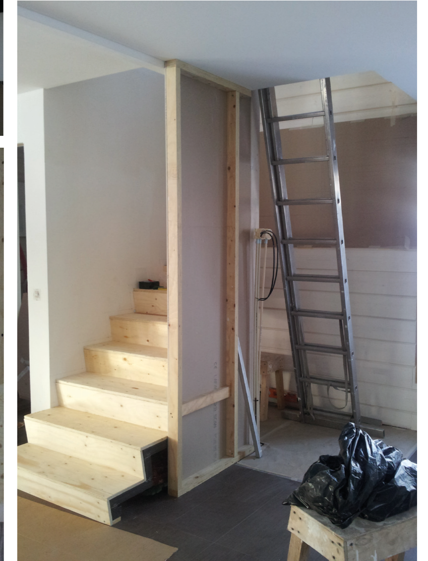
TYÖMAAKUVIA portaiden rakentamisesta. Portaiden vanerirunko päällystetään massiivisaarnella yläkerran parketin sävyyn. Kolmas askelma asettuu seinälinjaan pintakerroksen myötä.
