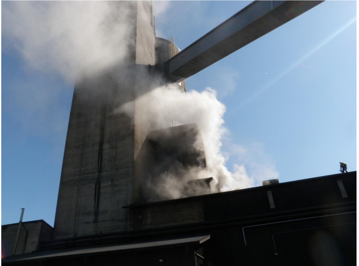
Kuvio 7. Rakennuspalo kaivoksen murskaamolla
