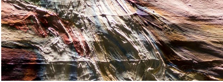
KUVA 22. Halkeamat keskitukiin kohdalla, sivuvalokuva.
