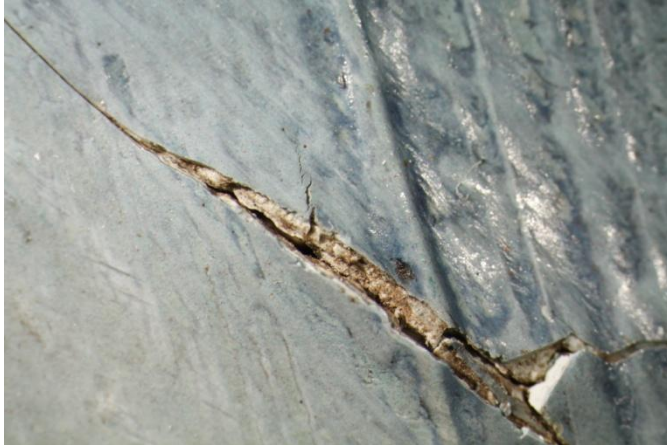
KUVA 24. Maalipinnan halkeama puvun alueella, 16 x suurennos.
