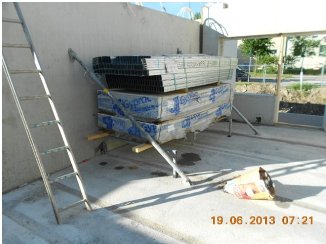
Kuva 11. Seinäelementti pystyyn tuettuna ja väliseinämateriaalit nostettuna telineiden päälle.
