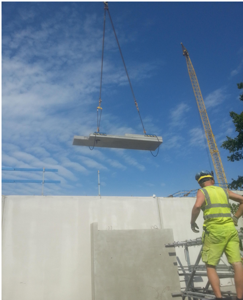
Kuva 8. Ontelolaatan nosto. Varmuusketjut ovat asianmukaisesti paikallaan. Kuva: Miika Piipponen
