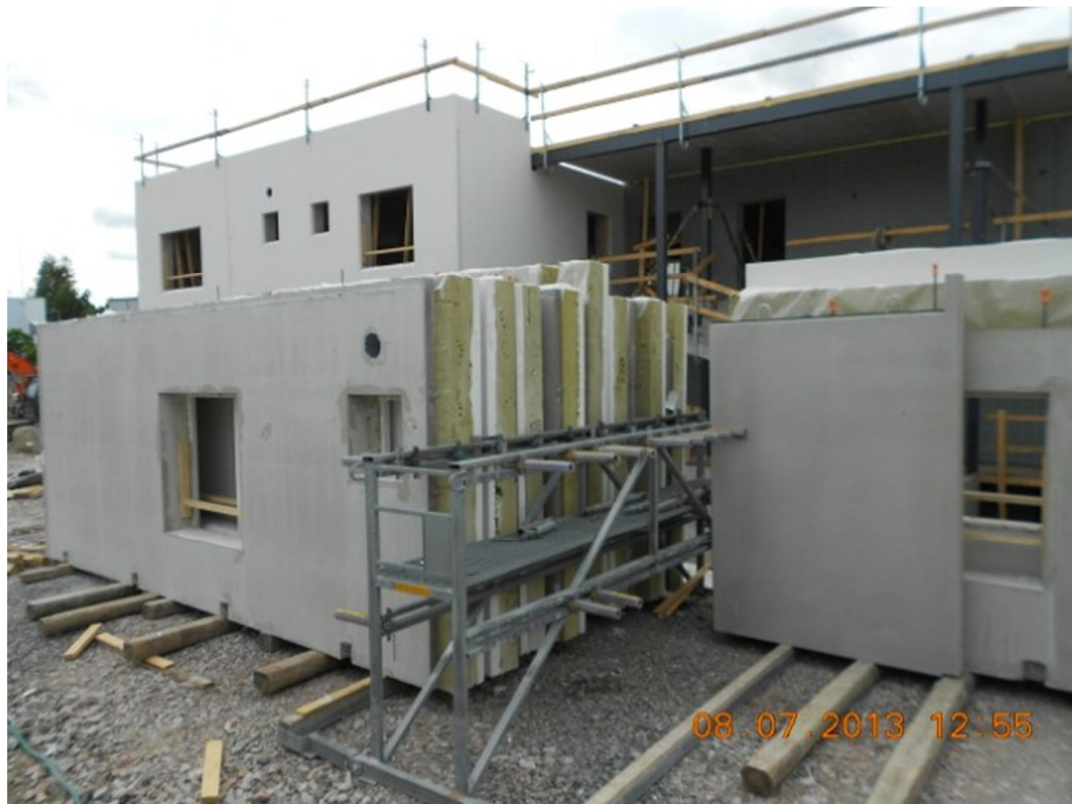
Kuva 4. Elementtifakki Ahjon työmaalla. Kuva: Miika Piipponen
