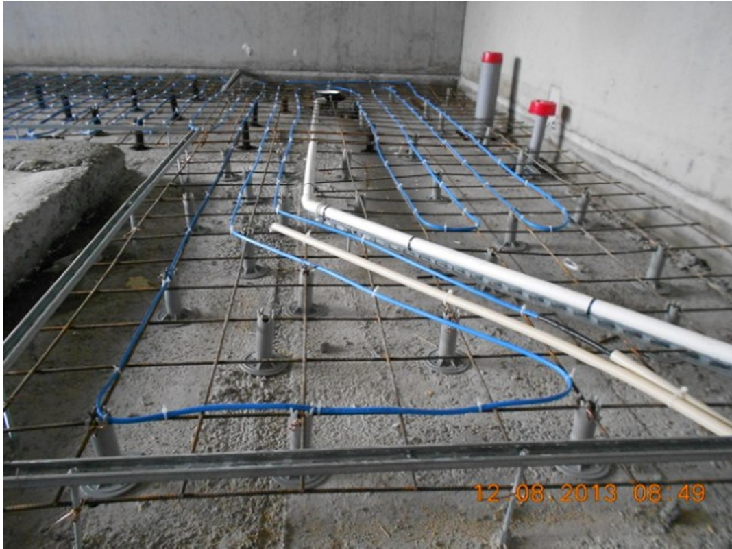
Kuva 10. Pesuhuoneen lattia valmiina kaatovalua varten. Kuva: Miika Piipponen
