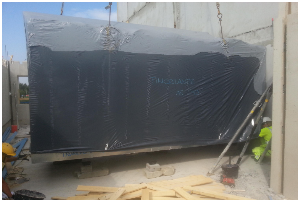
Kuva 15. Kylpyhuone-elementin asennus elementtirunkoisessa rakennuksessa. Kuva: Miika Piipponen
