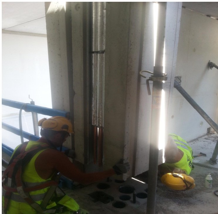
Kuva 12. Elpo-talotekniikkahormin asennus. Kuva: Miika Piipponen
