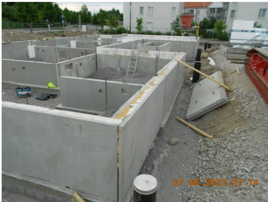
Kuva 5. Rakennuksen sokkelielementit paikalleen asennettuna, sekä anturan korotus valettuna.
