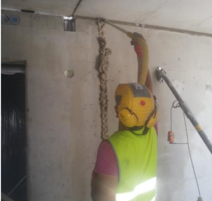
Kuva 13. Pystysaumapumppaus. Kuva: Miika Piipponen
