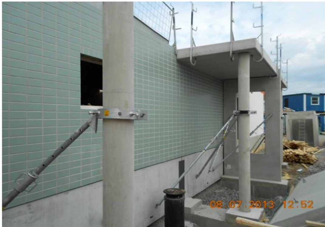
Kuva 6. Pilari- ja pielitelementit pystyyn tuettuna. Kuva: Miika Piipponen
