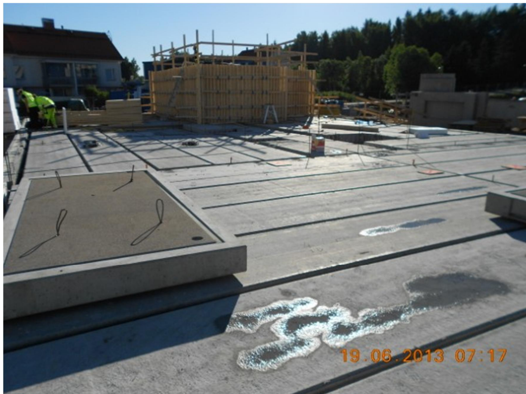
Kuva 9. Ontelolaatasto ennen saumavalua. Taustalla väestönsuojan muotti. Kuva: Miika Piipponen
