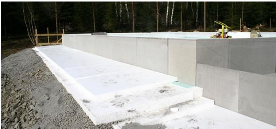
Kuva 4 EPS-lämmöneriste asennettu routasuojaksi perusmuurin viereen
