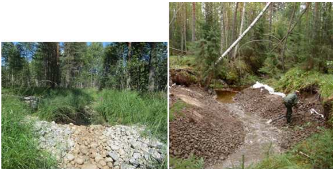
Kuva 4. Kivinen pohjapato ja korjatut penkat. (Kuvat: Rauno Homanen & Janne Raassina.)
