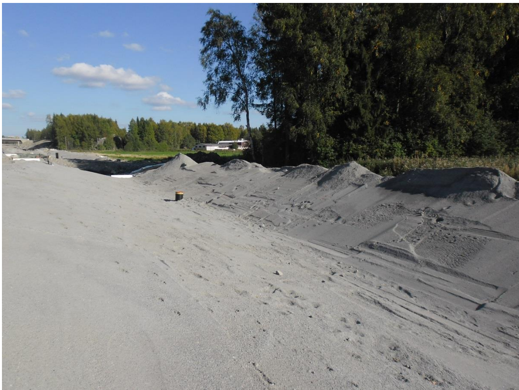
Kuvio 11. Suoja- ja salaojakerroksen tekoa.
