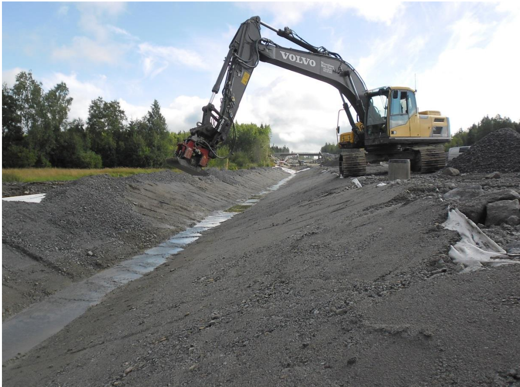
Kuvio 7. Bentoniittimaton asennusalusta tiivistettiin hydraulisella tärjelyvyllä.
