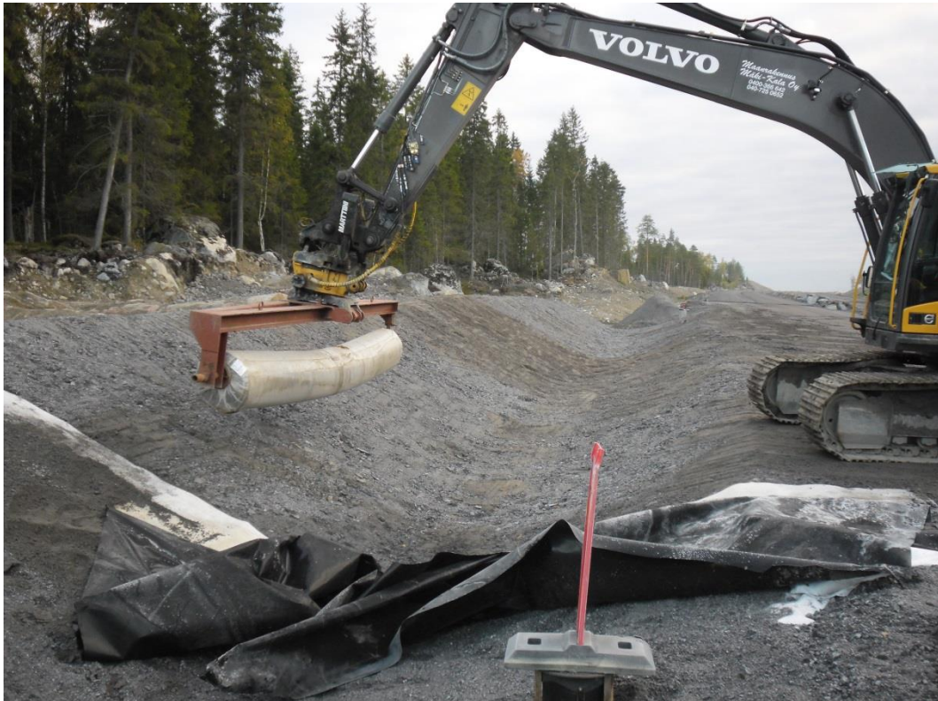
Kuvio 10. Mattojen levitystä korkean takaluiskan kohdalla.
