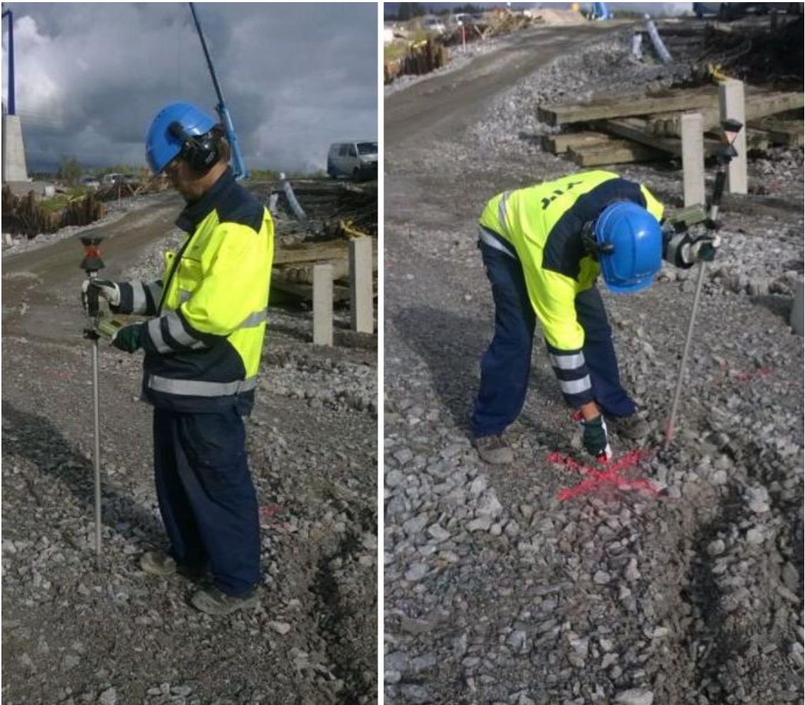
Kuva 8. Kuvassa mittamies mittaa ja merkitsee paalun paikan perinteisellä takymetrimittauksella.
