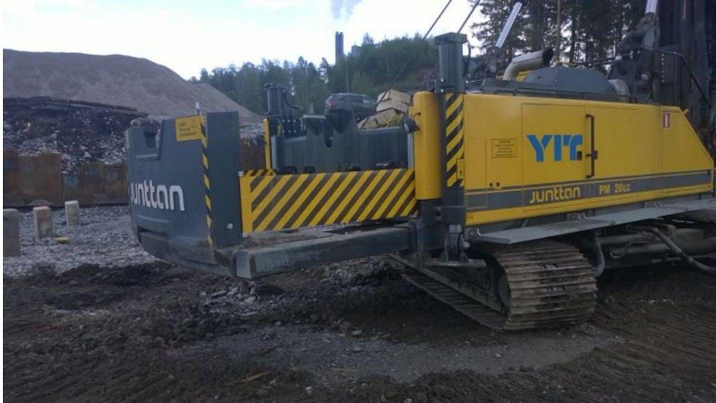
Kuva 4. Kuvassa paalutuskoneen takaosassa oleva säädettävä vastapaino, jonka avulla paalutuskone pysyy vakaana, kun paaluja joudutaan kallistamaan tai kurottamaan.
