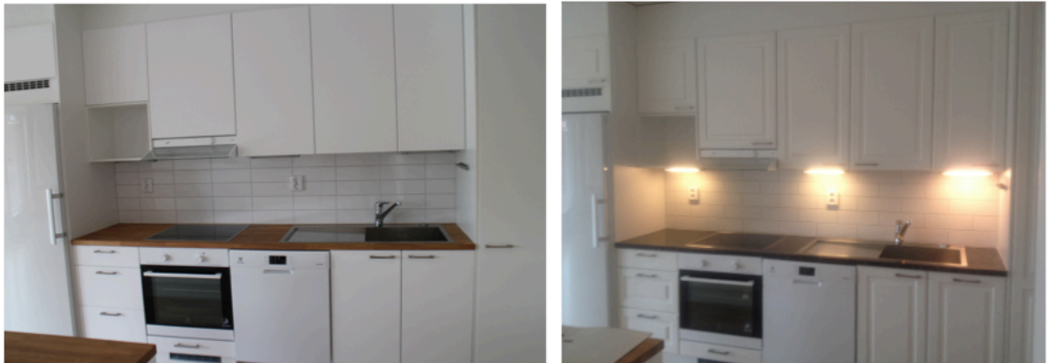
Kuva 9. Samasta asuntotyyppistä otetut kuvat, vasemmalla vakio oikealla teetetty pieniä muutostöitä ovilevyihin sekä kaakeliasennukseen.
