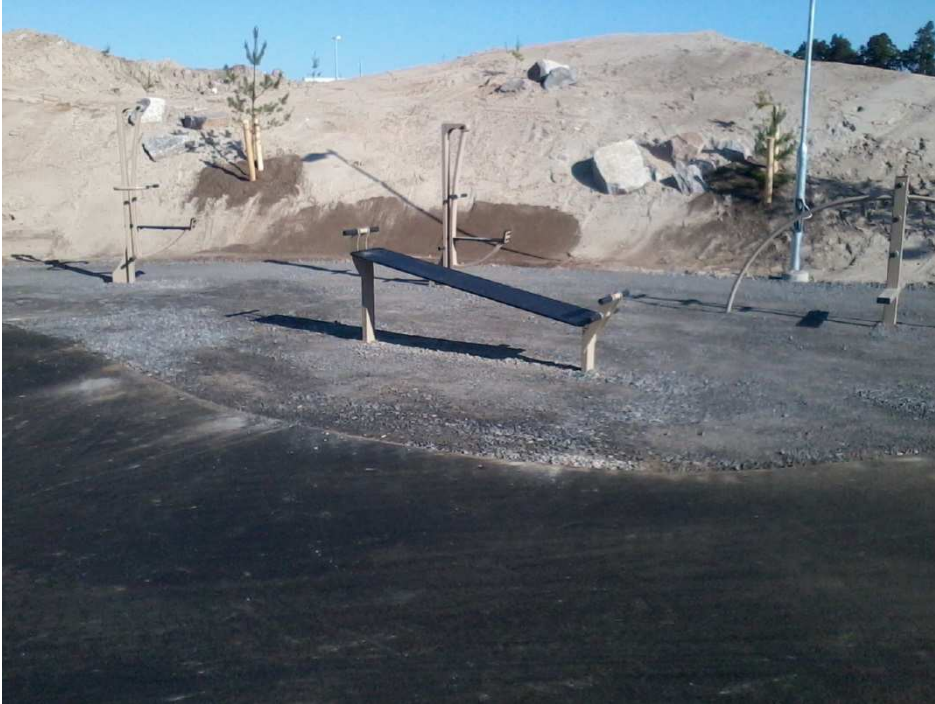
KUVA 1. Lukion pihan urheiluvälineet ovat valettuna paikoilleen
