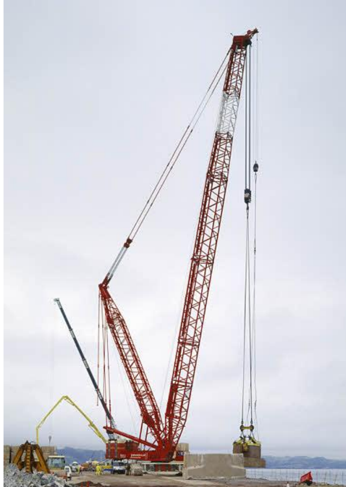
Kuva 1 Liebherr LR1750-mallinen ristikkopuominosturi työmaalla. [10.]
