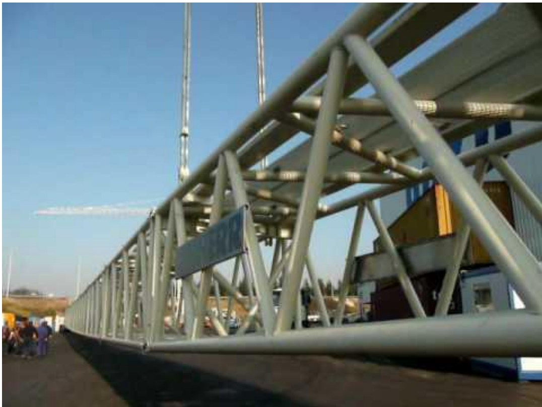
Kuva 2 Liebherrin valmistama ristikkopuomi. Puomin päällä näkyy kävelytasanne.[11.]
