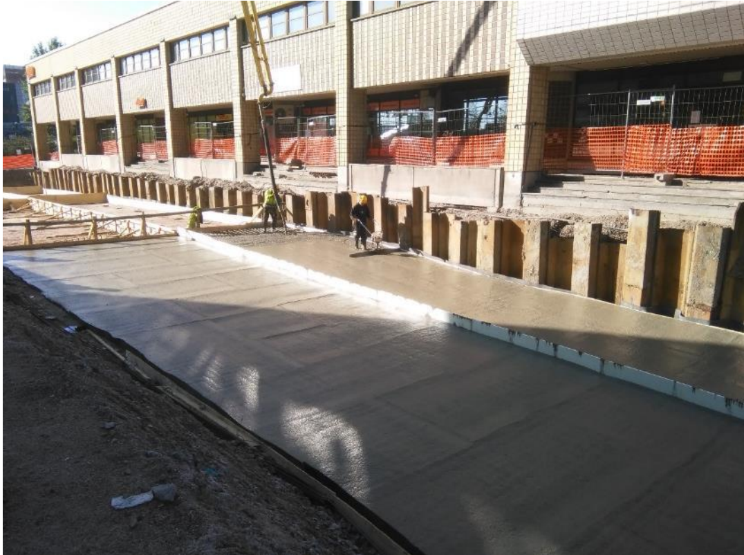
Kuva 10. Paalulaattojen pinnat käsitellään tärypalkilla.
