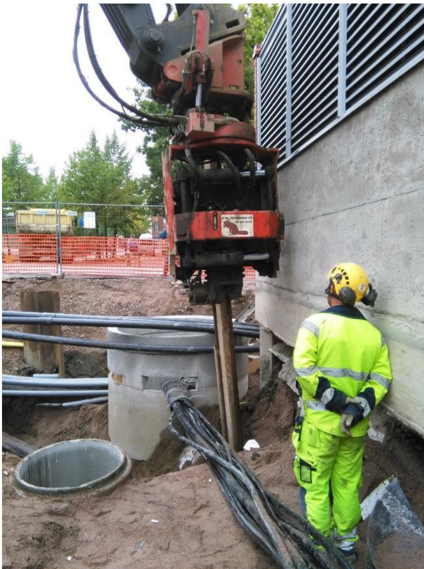
Kuva 16. Teräsponttia asennetaan kaivinkoneeseen liitetyllä Movax-ponttivasaralla maahan.
