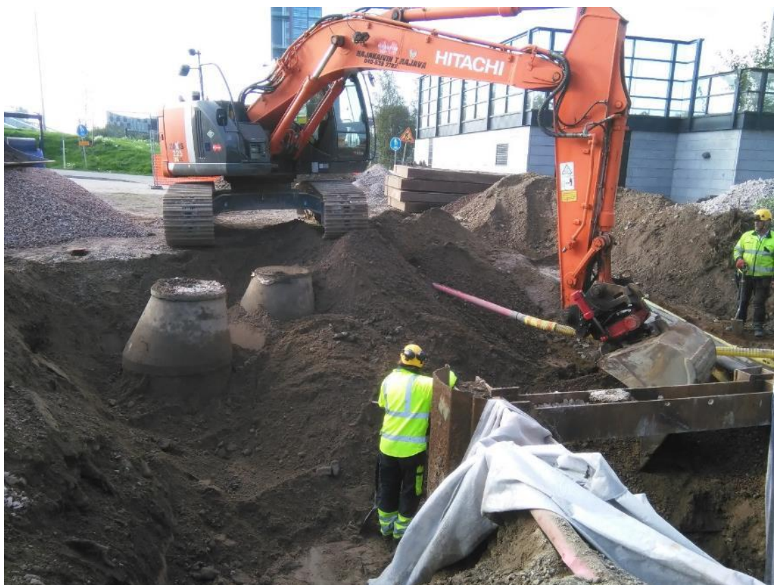
Kuva 18. Olemassa olevia putkia ja kaapeleita kaivetaan esille.
