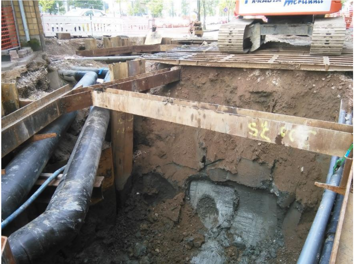
Kuva 13. Kaivanto on tuettu teräsponteilla ja H-palkeilla. Lisäksi kaivinkone työskentelee ajosiltojen varassa.
