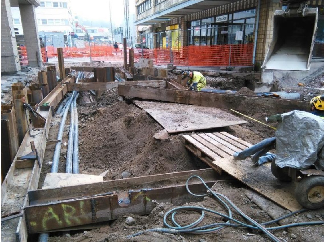
Kuva 15. Teräsponteille tehdään yläpään tuennat H-palkeista. Ne hitsataan toisiinsa kiinni.
