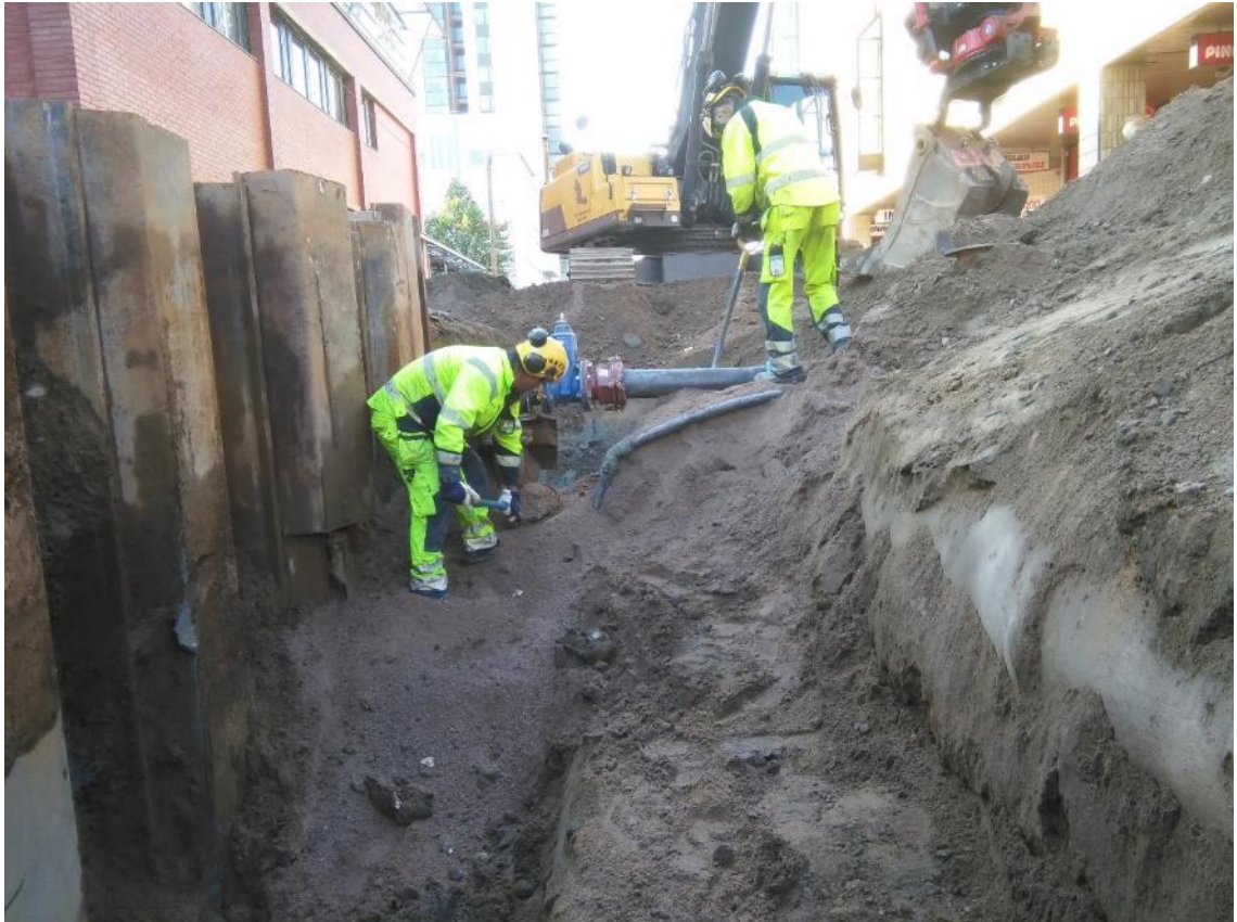
Kuva 3. Vesijohtoa kaivetaan esiin. Vieressä on vanha viemäri- ja sadevesilinja. Kaivanto on tuettu ponttiseinällä.
