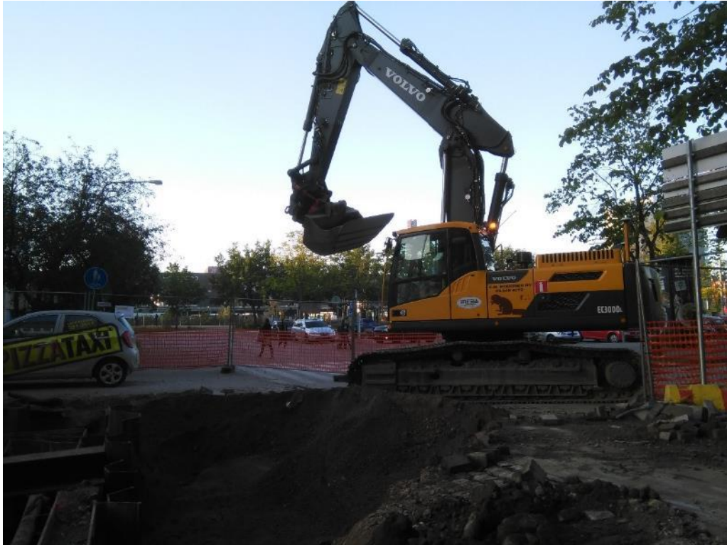
Kuva 2. Työmaan resurssit määrittelevät kaluston, jolla työt voidaan suorittaa. Kuvassa yrityksen uusi kaivinkone, jonka hankinta määräytyi tämän työmaan tarpeiden mukaan.
