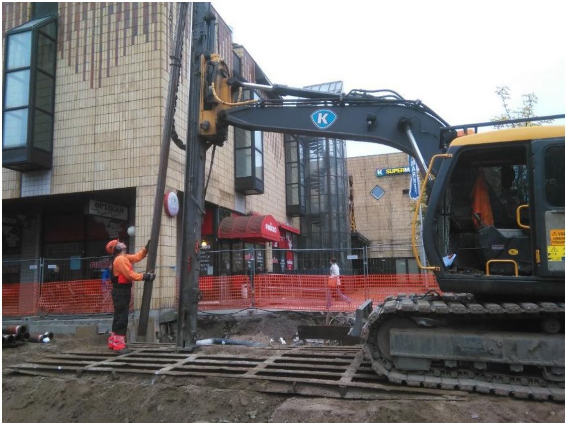
Kuva 11. Paalutustyö käynnissä. Teräspaalu nostetaan pystyyn ja paalutuskone työskentelee ajosillan päällä.
