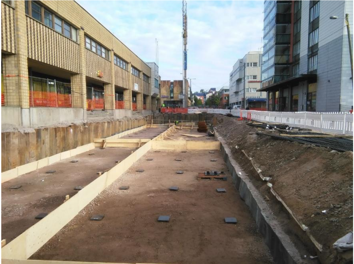
Kuva 9. Paalulaatan pohjat ja muotit ovat valmiina raudoitusta varten.
