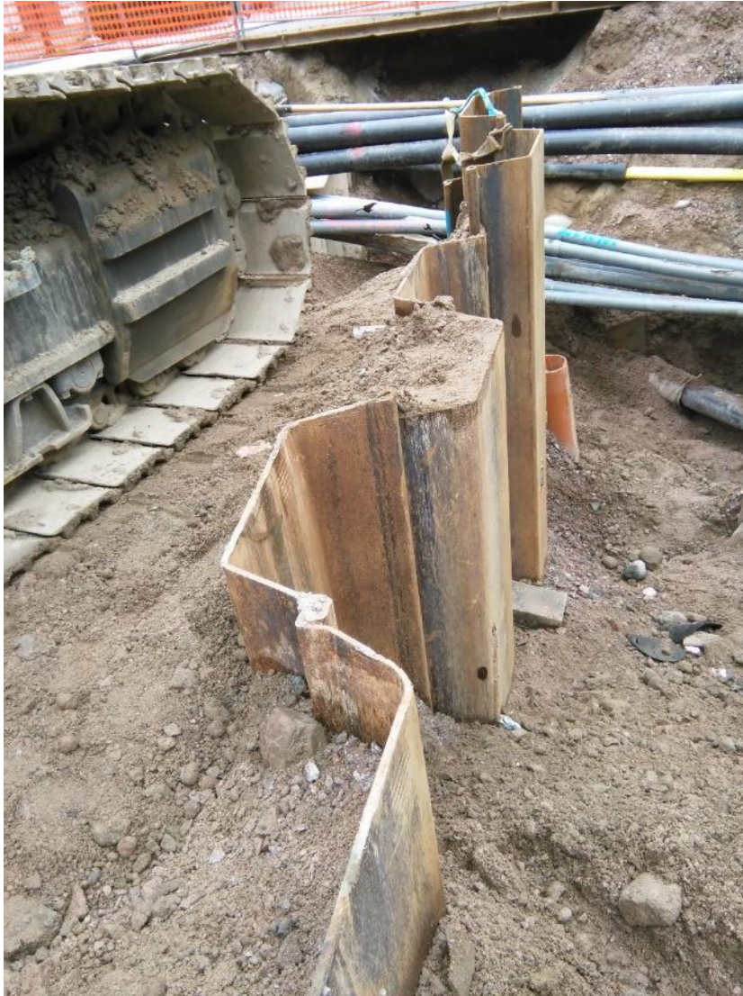
Kuva 14. Larsen-teräspontit ovat liitettyinä toisiinsa.
