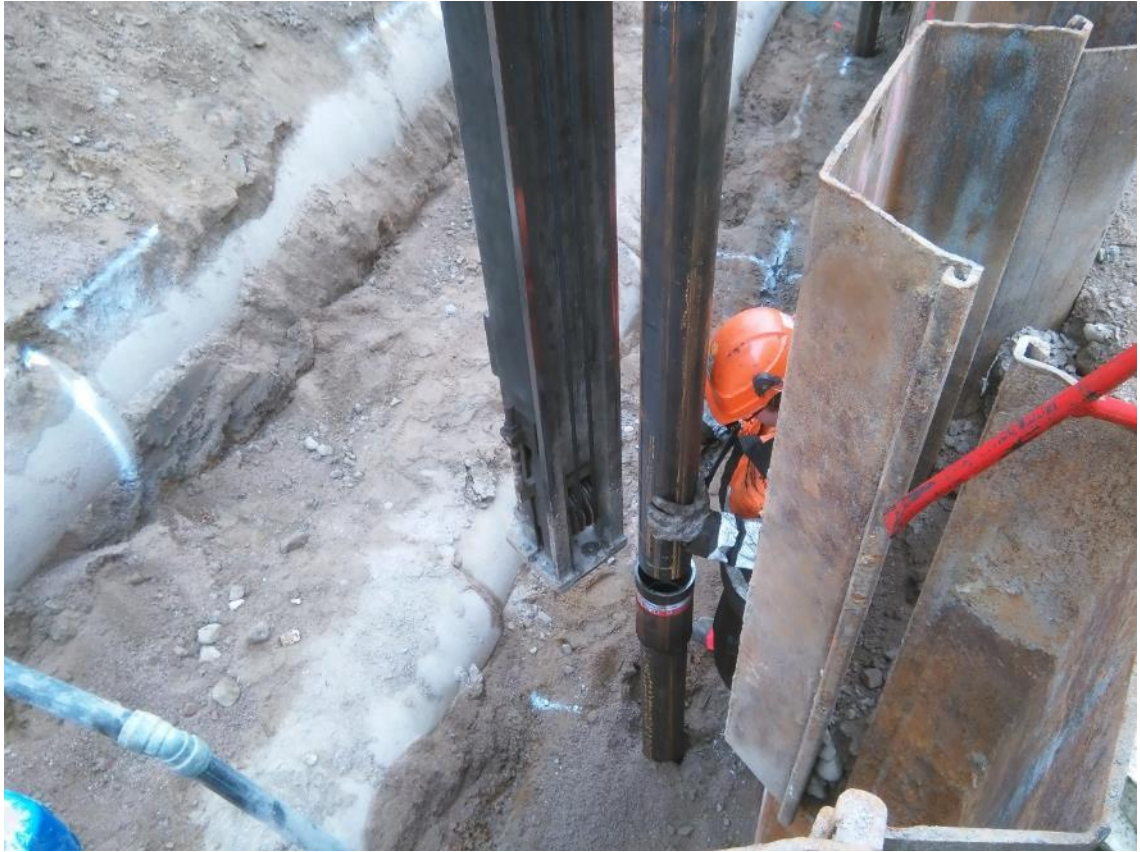
Kuva 12. Teräsputkipaaluja jatketaan.
