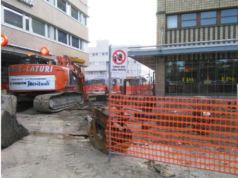
Kuva 4. Työmaa-alue on aidattu ulkopuoliselta liikenteeltä.
