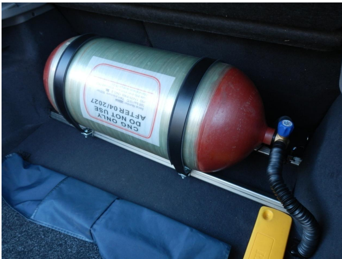
Kuva 20. Kaasupullo kiinnitettynä. Pantojen ja säiliön välissä kumi. Kaasuputken liitokset kiristetty ja suojaputket paikoillaan sekä tavaratilan verhoilu viimeisteltynä.
