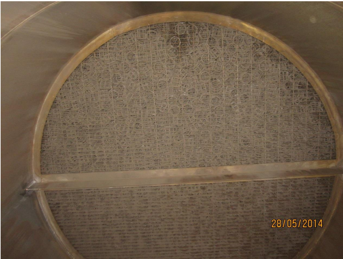
KUVA 10. Täytekappalekerros alhaalta päin kuvattuna
