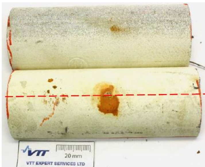
Kuva 7. Putken ulkopinta. Vuotokohta sijaitsee pituussuuntaisen hitsin kohdalla. Hitsi on merkitty kuvaan punaisella katkoviivalla. (9)
