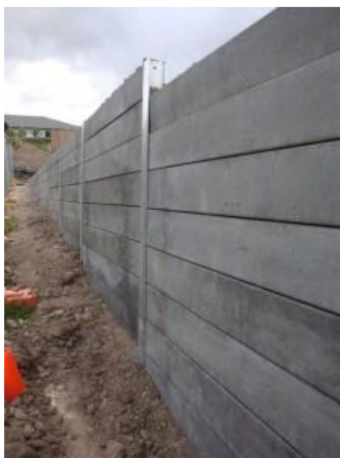
Kuva 3 Ratapölkkyistä tehty tukimuri Australiassa (20)
