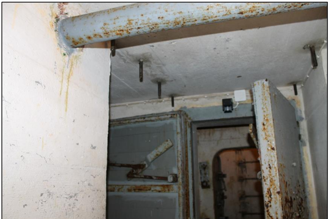
KUVA 12. Vierailijan on varottava katossa olevia terästappeja ja muita rakenteita. Kuva on korsusta nro 63.
