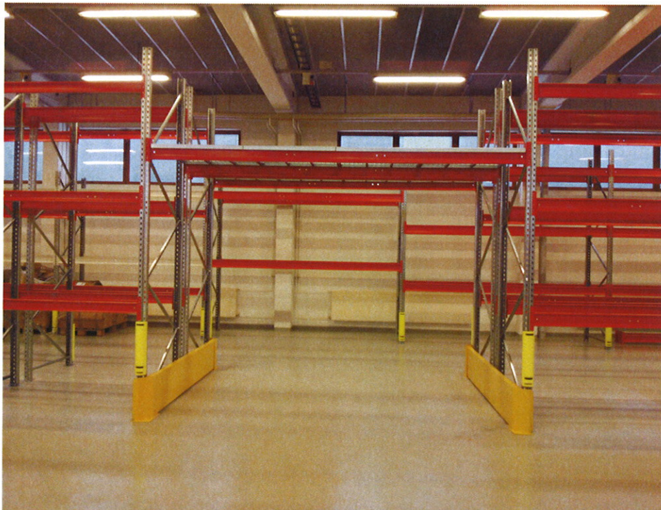
Kuva 7. Tunneli ja törmäyssuojat.
