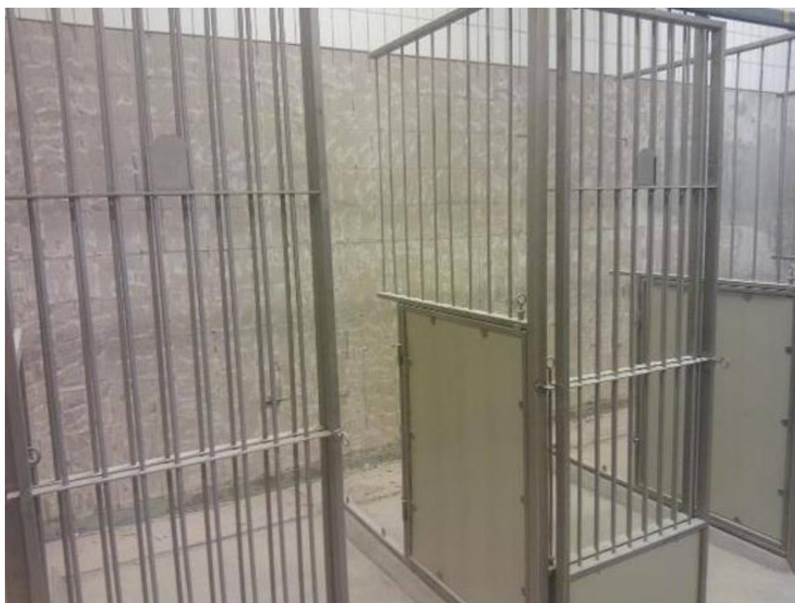
Kuva 3. Saneerattava tila seinälaattojen purun jälkeen.
