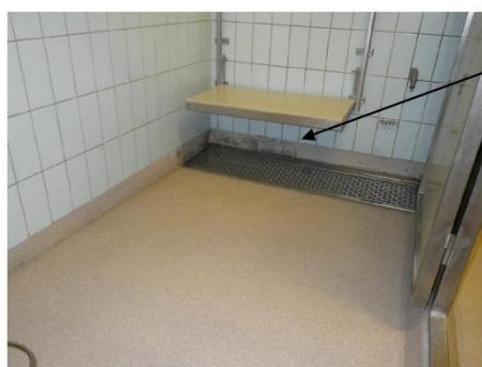
Eläintila. Mittaukset tehtiin seinien alaosista.
