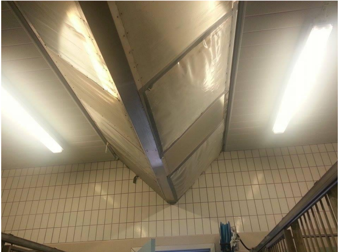
Kuva 8. Ilmastointikanavien pääte-elimet suojattuina.
