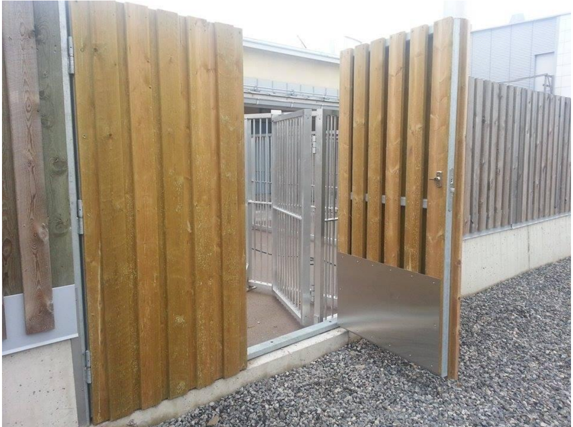
Kuva 7. Oviaukko varaukottarhasta työmaa-alueelle.
