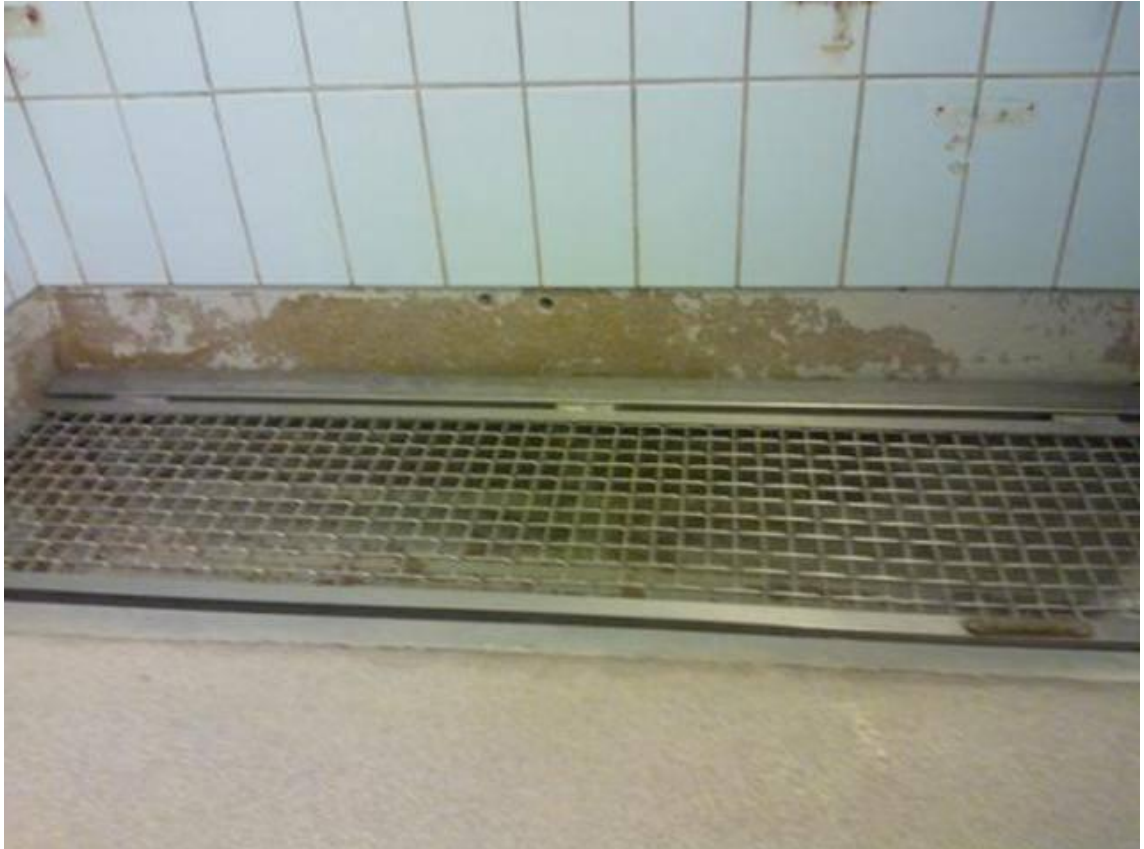
Kuva 4. Tilan seinän alareuna lattiakourun yläpuolelta.
