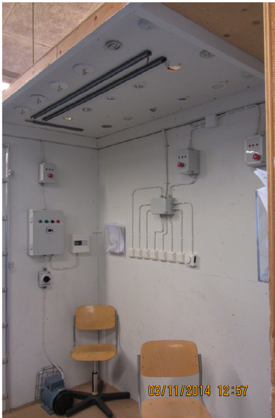
Kuva 15. Valonlähteiden tutkimiseen käytetty testikoppi
