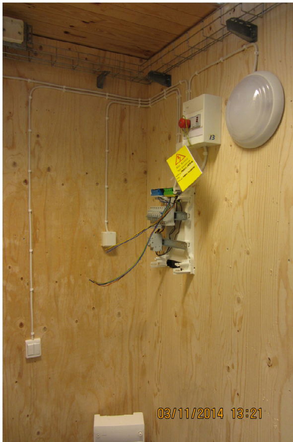
Kuva 13. Valaisinkytkentä seinälle
