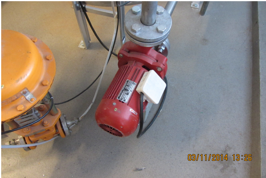
Kuva 30. Kiertovesipumppu
