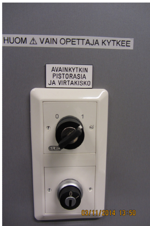
Kuva 8. Opettajan hallinnoima turvakytkin
