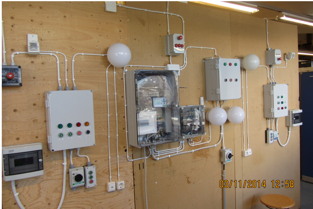
Kuva 12. Kytinlaiteasennuksia
