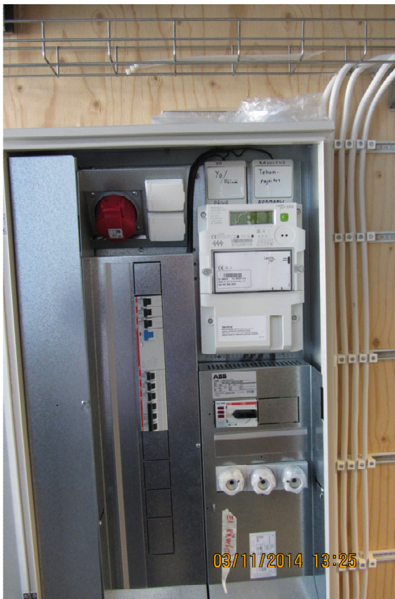
Kuva 25. Valmis mittarointityö
