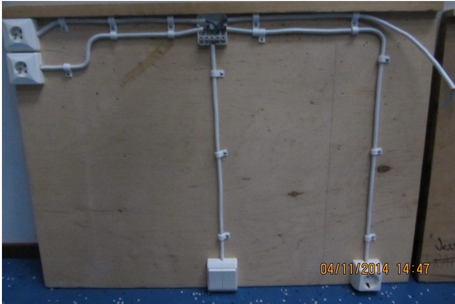
Kuva 14. Valaisinkytkentä asennusalustalle
