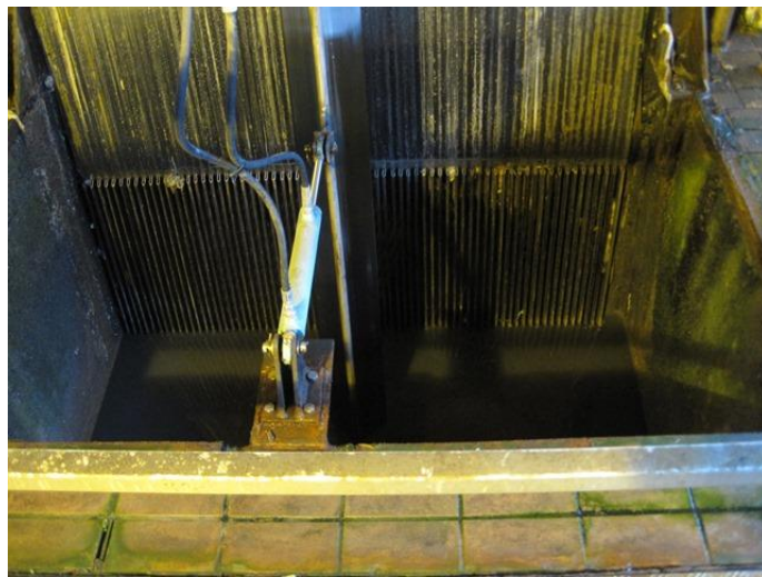
Kuva 3. Vedenpuhdistuslaitoksen välppä [17.]
