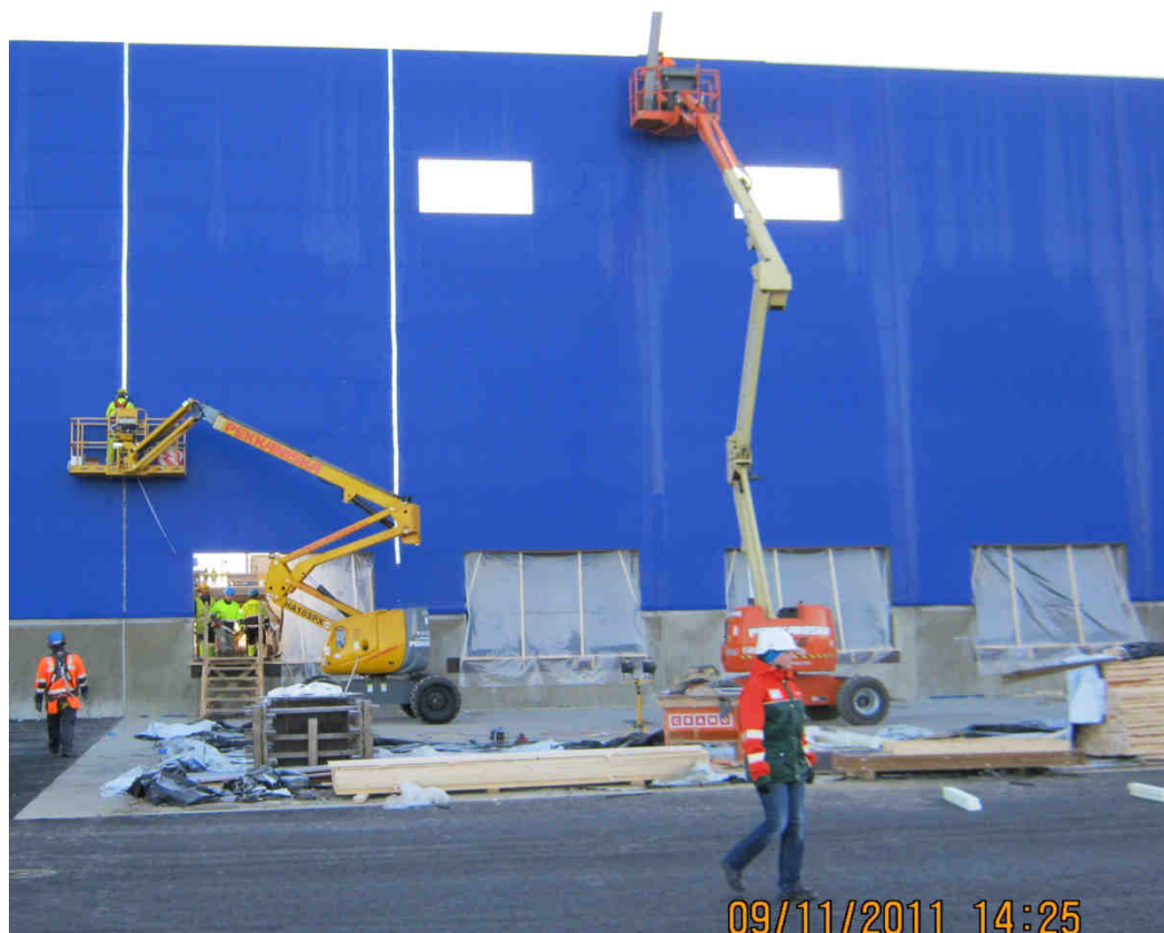
Kuva 19. Julkisivuelementtien tilkitseminen ja saumapelitys käynnissä nivelpuominostimilla. (Peab Oy 2011.)
