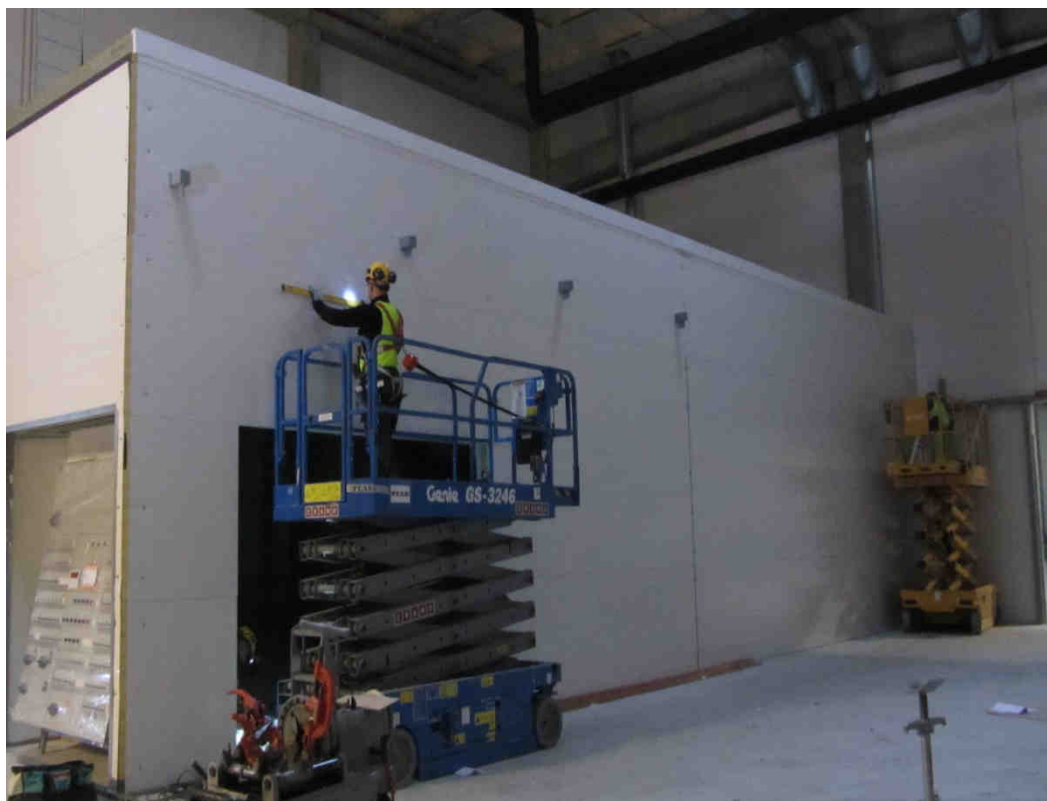
Kuva 17. Läpivientien teko käynnissä akkukäyttöiseltä saksilavalta. (Peab Oy 2012.)
