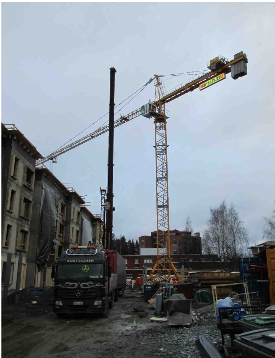
Kuva 9. Elementtikuorman purku ajoneuvonosturilla, torninosturin ollessa varattuna elementtiasennukseen. (Leinonen 2013.)
