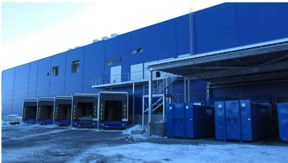
Kuva 22. Lastauslaituri- ja jätehuoltoalue otettu käyttöön. (Peab Oy 2012.)
