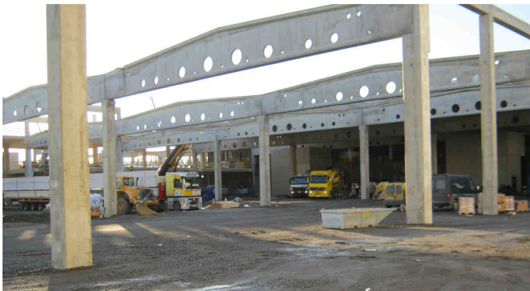
Kuva 21. Ajoneuvoliikennettä rungon sisällä ennen maanvaraisen lattiaita. (Peab Oy 2011.)
