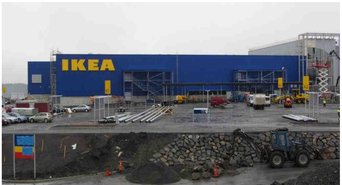
Kuva 1. Julkisivu länteen huhtikuussa 2012 (Peab Oy 2012.)
