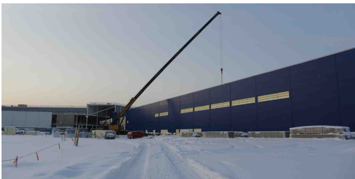
Kuva 7. Nostotyö ajoneuvonosturilla 3.kerrosn iv-konehuoneeseen ulkopuolelta kuvattuna (Leinonen 2012.)
