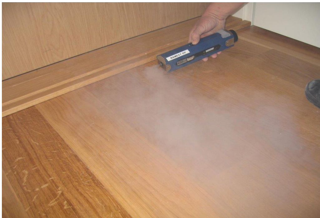
KUVA 5. Savukone, Ilmavuotoa kynnyksen alta (Ramest Oy, 2013)
