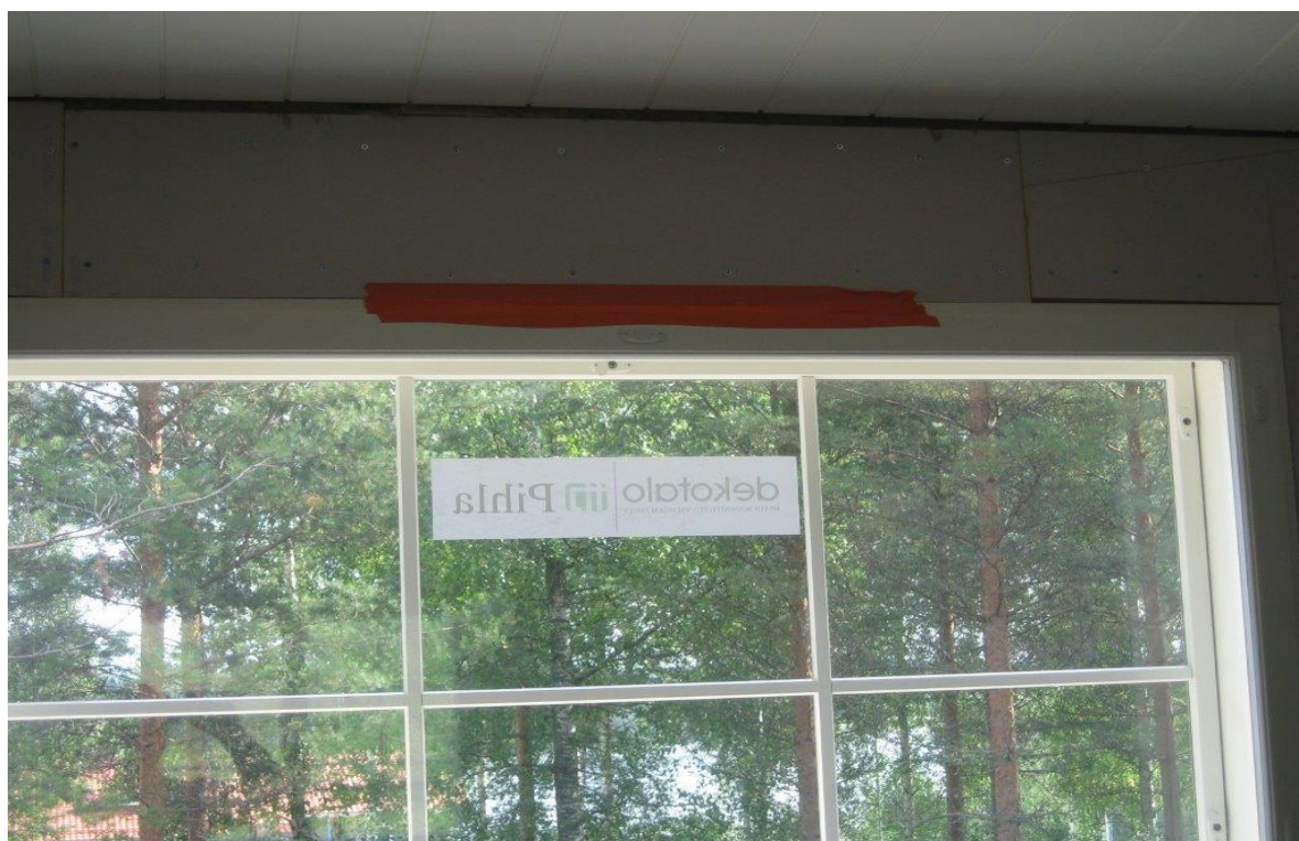
KUVA 2. Karmiventtiilin aukko tiivistettynä teipillä (Ramest Oy, 2013)
