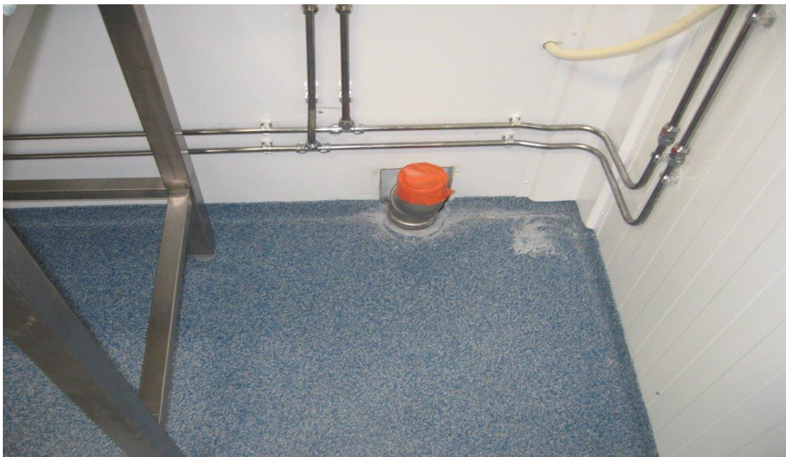
KUVA 3. Viemäriputken tiivistys teipillä (Ramest Oy, 2013)
