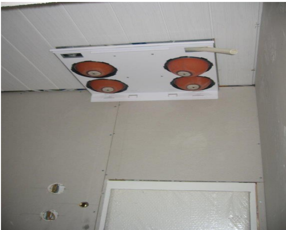
KUVA 4. IV-koneen läpivientien tiivistäminen kumi-ilmapalloilla (Ramest Oy, 2013)
