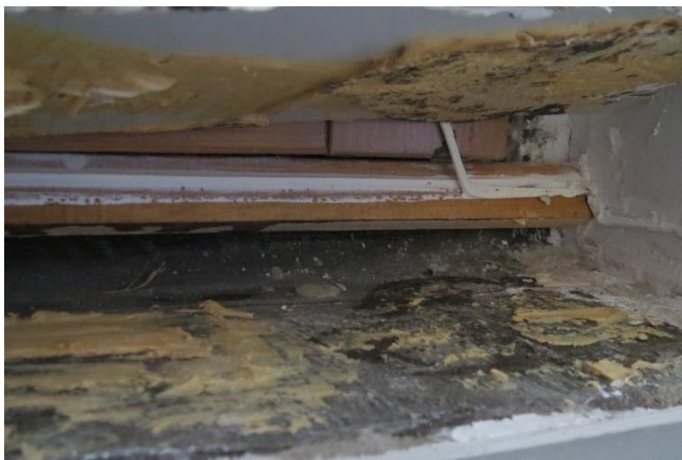
Kuva 23. Rakenneavauksen perusteella on ikkunaan liittyvä tiivistys tehty tiivistyskorjaussuunnitelmien mukaisesti.
