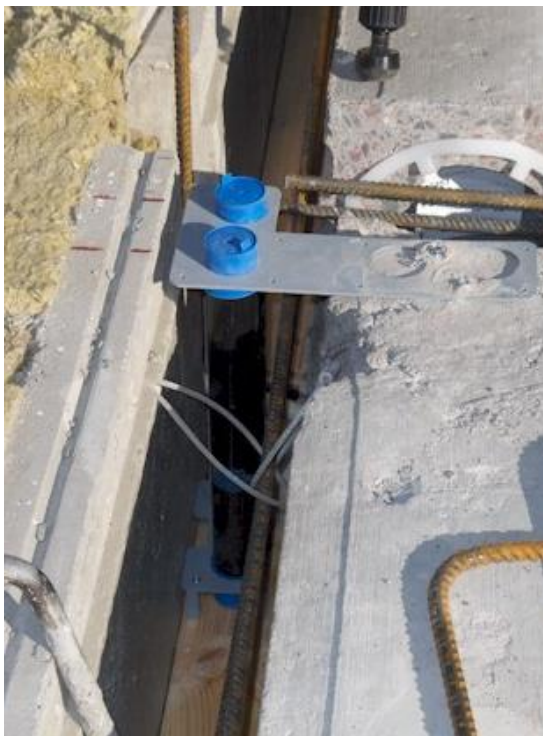
Kuva 7. Sewatek-läpivientikappale ontelokentässä [11.]
