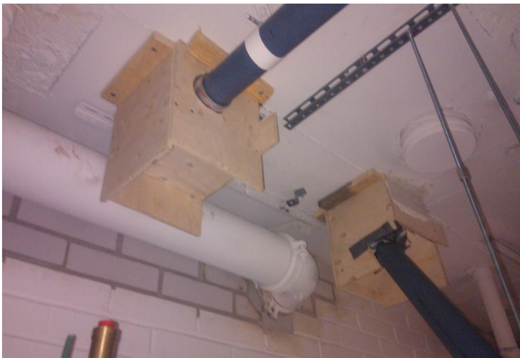
Kuva 11. Muoviviemäriputket lähtevät holvipinnasta vinoon. Kuvassa on ääniloukkujen muotit.
