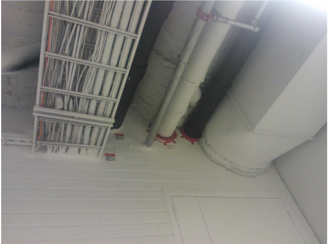
Kuva 5. Yhdistelmäläpivienti muuratun seinän läpi
