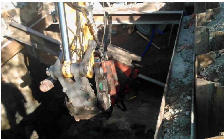
Kuva 19. Palkin ujutus kaivantoon
