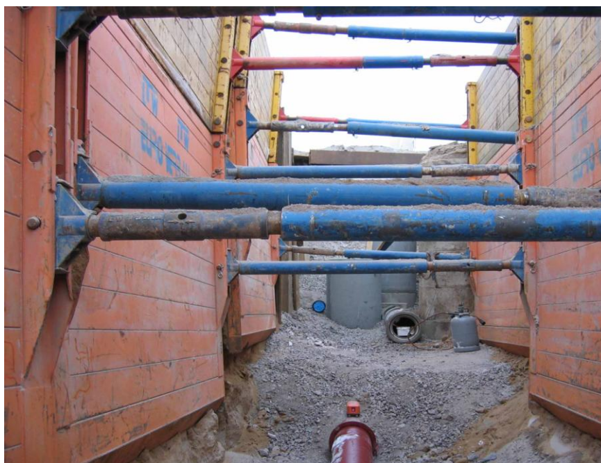
Kuva 11. Näkymä kaivannosta tuentaelementtien suojasta
