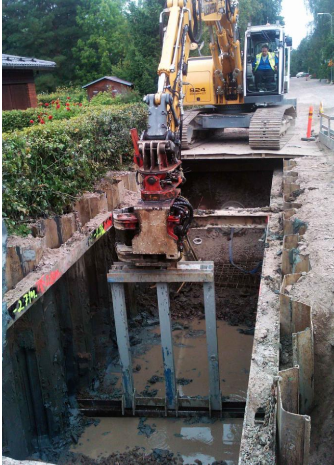
Kuva 17. I-palkin painaminen haarukan avulla
