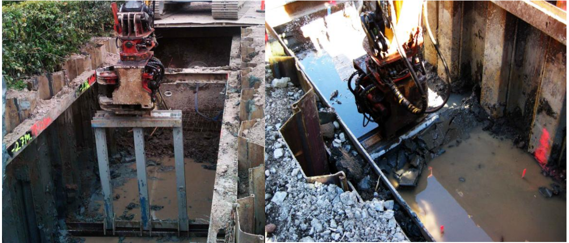
Kuva 20. Palkin painaminen määräsyyvyteen
