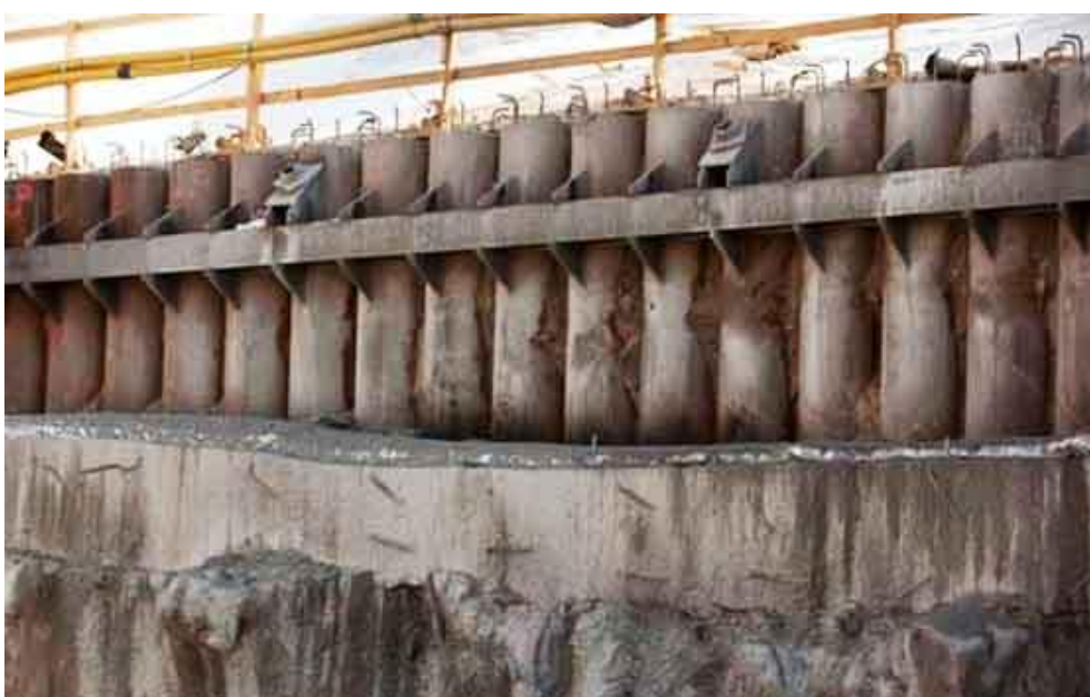
Kuva 9. Porapaaluseinä asennettuna Kalasatamassa 2012 [15]
