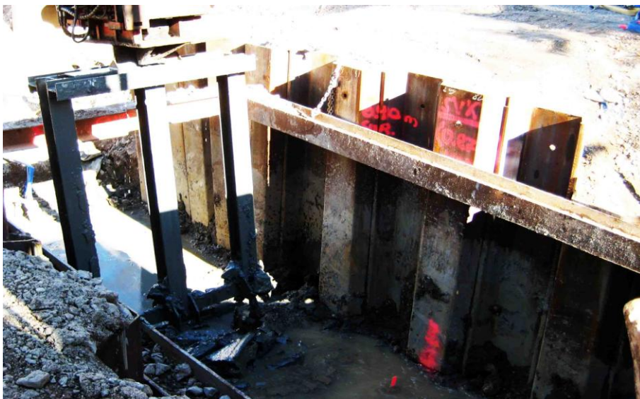
Kuva 21. Haarukan nostaminen
