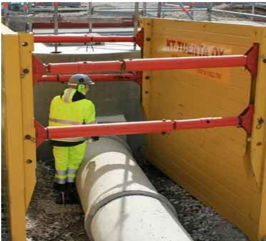
Kuva 5. Tuentaelementti käytössä [12]
