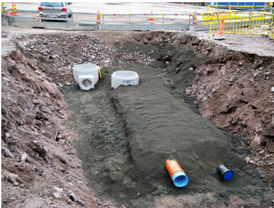
Kuva 10. Luiskattu putkikaivanto
