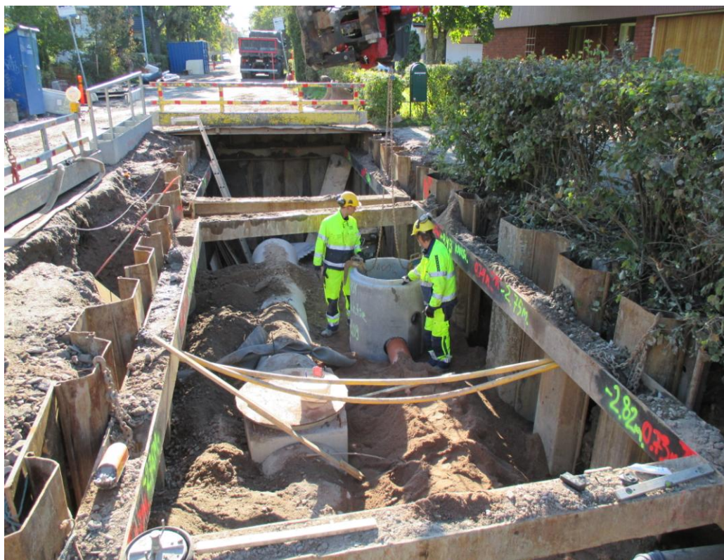
Kuva 12. Teräsponttiseinä kaivannon tukirakenteena
