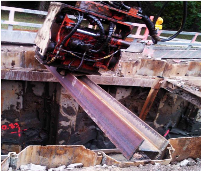
Kuva 16. I-palkin asennusvaihe
