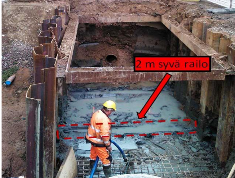
Kuva 22. I-palkin asennuksen jälkeinen railo kaivannon pohjalla
