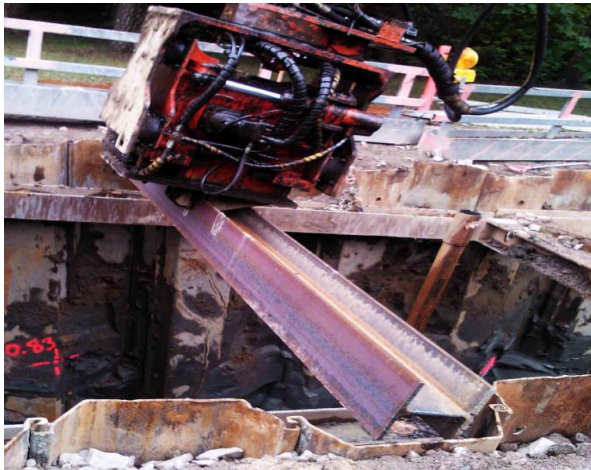
Kuva 18. I-palkin leikkaus määrämittäiseksi
