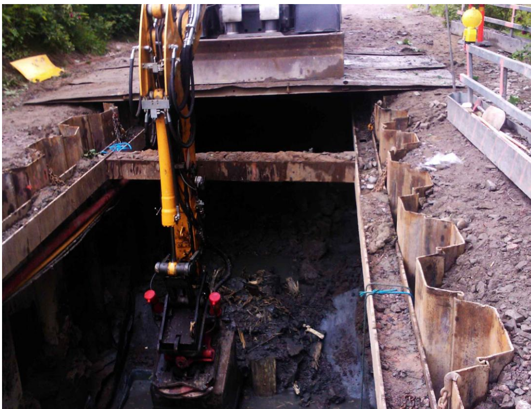
Kuva 6. Lukkoon asennetut teräsponttiseinämät ja yläpuolinen tukikehikko
