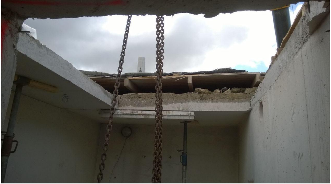
Kuva 11. Hissikuiluelementtien lasku puretusta katosta.
