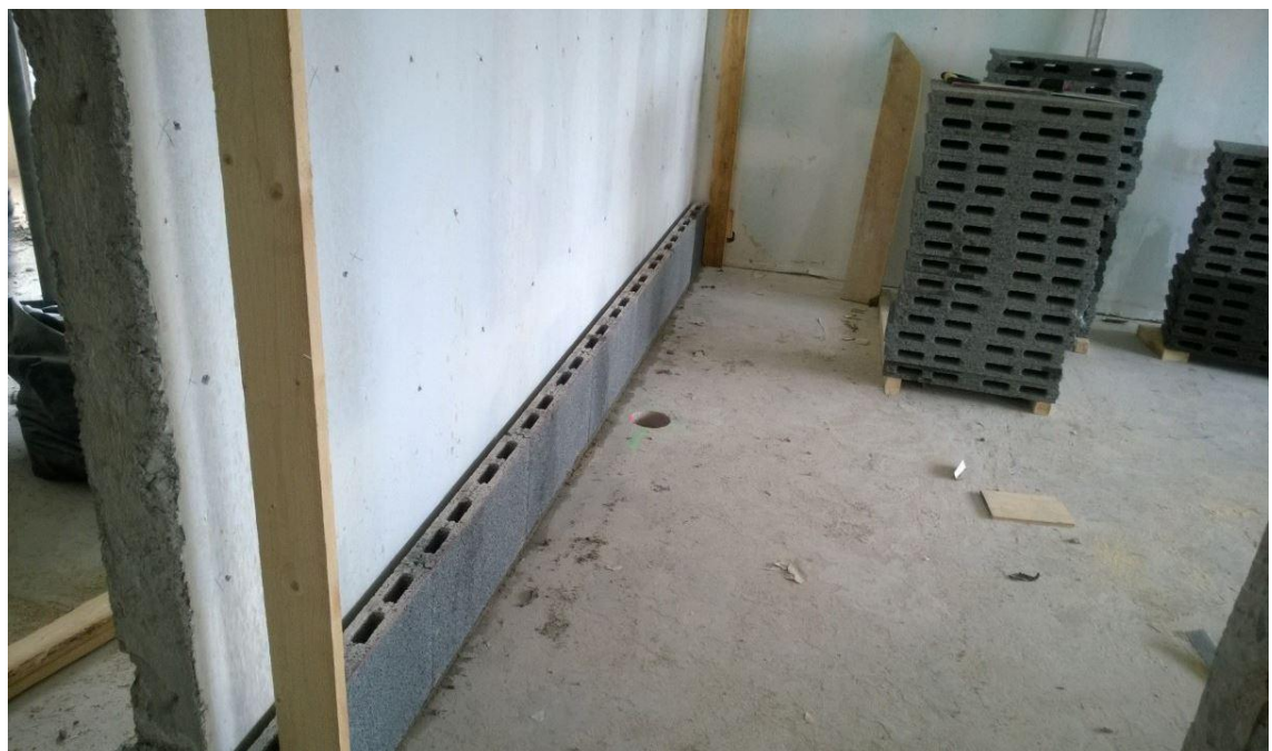
Kuva 14. Asuntojenvälisien seinien äänieristävyyden parantaminen harkoilla.
