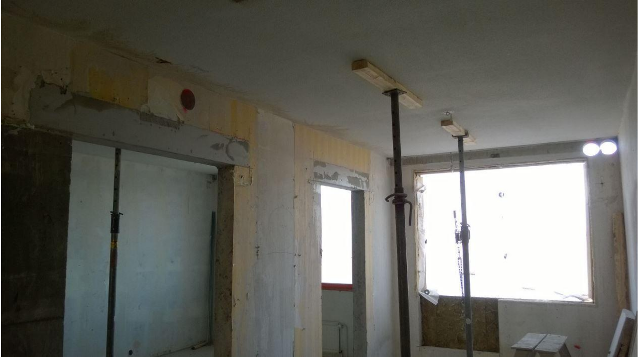
Kuva 9. Väliaikaiset tuennat ja ovenylityspalkit.
