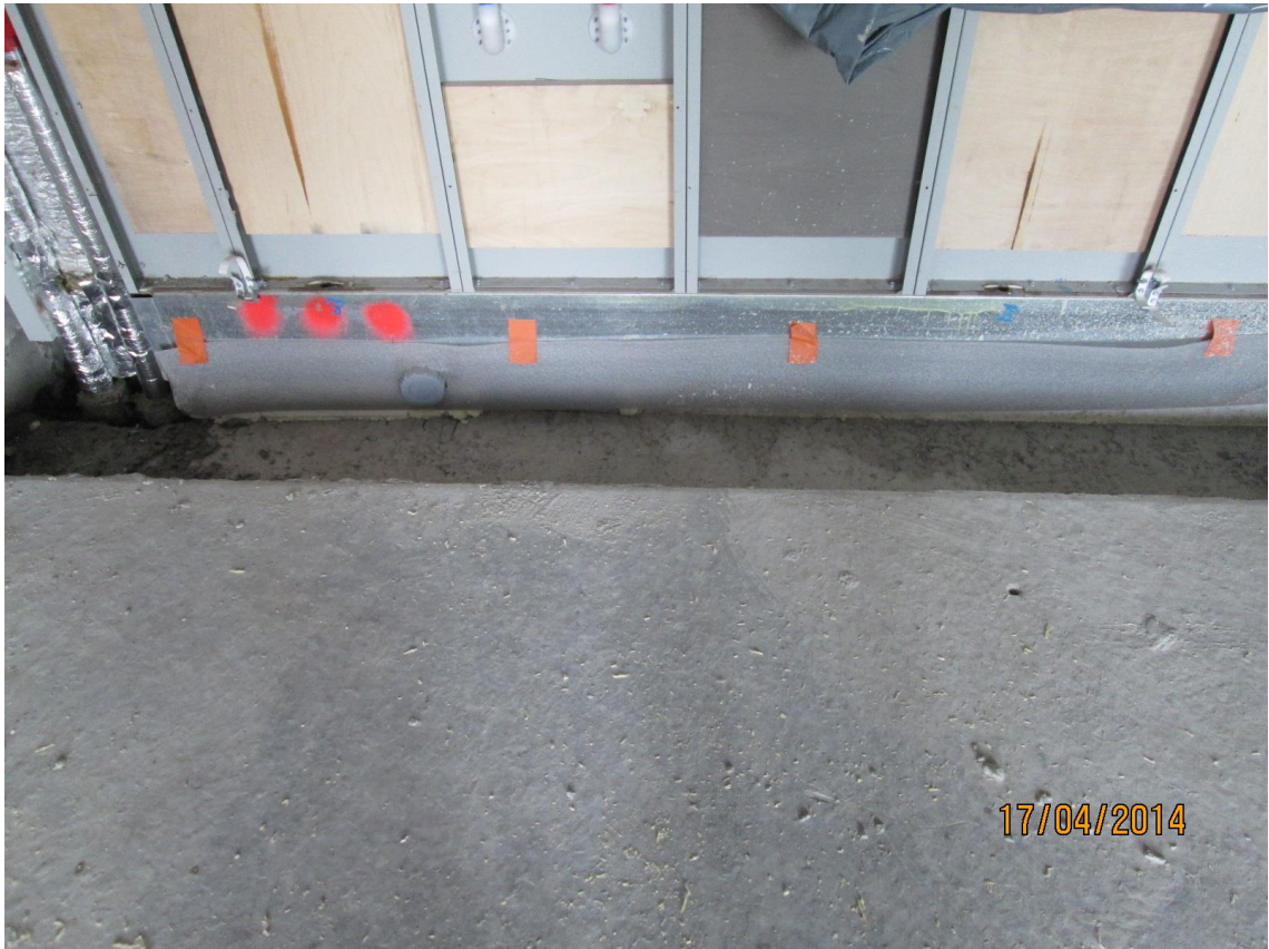
Kuva 5. Kylpyhuone-elementti valmisteltuna reunavaluun
