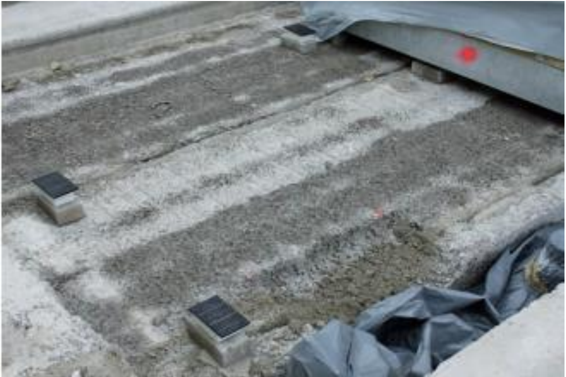
Kuva 4. Välikkeet mitattuna kololaatan syvennyksessä [6.]
