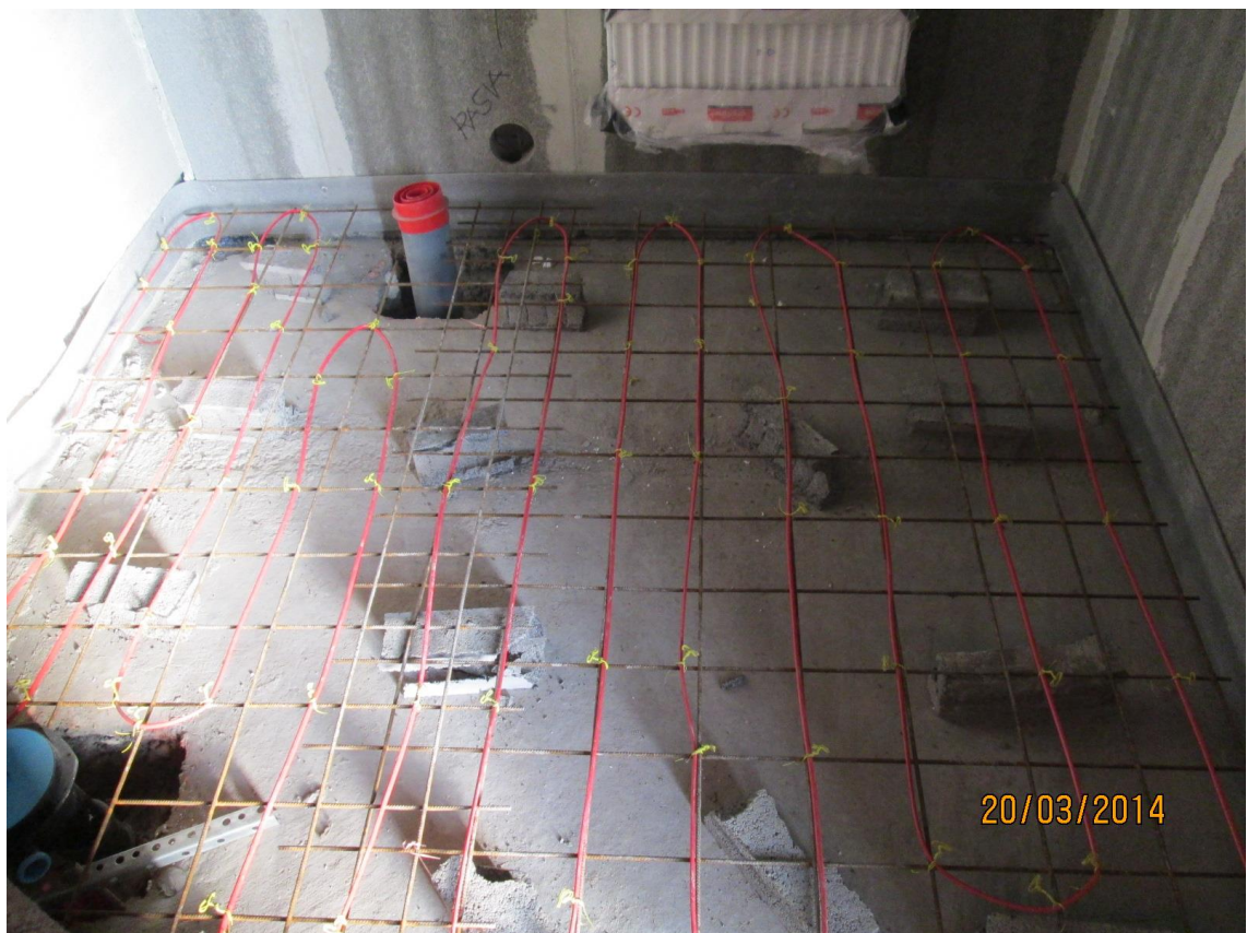
Kuva 6. Kylpyhuoneen lattia valmiina lattiavaluun
