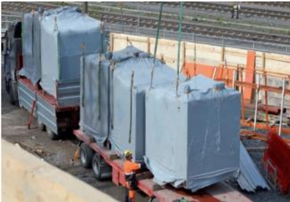
Kuva 3. Kylpyhuone-elementtien nostot tapahtuvat suoraan kyydistä. [6.]
