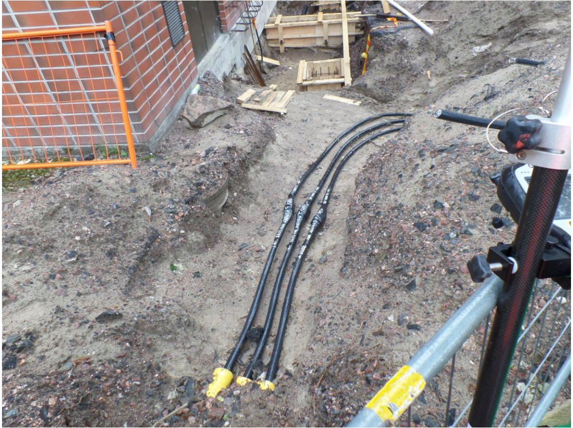
Kuva 11. Kaapeleihin tehdyt kj-jatkot vanhan muuntamon edessä
