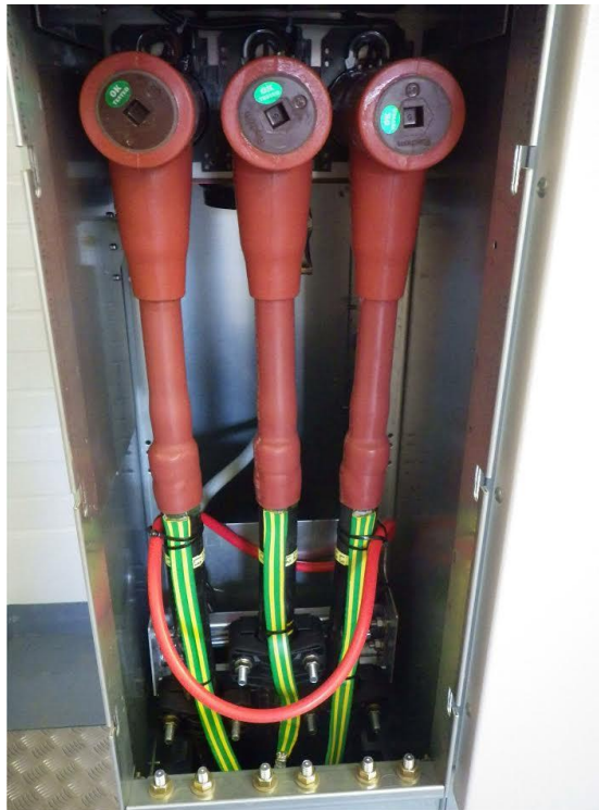
Kuva 13. Kj-kojeistoon tehdyt kulmapistokepäätteet
