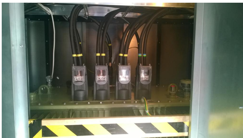
Kuva 9. Muuntajalle tehty kosketussuojaus ja kaapeleiden asennus
