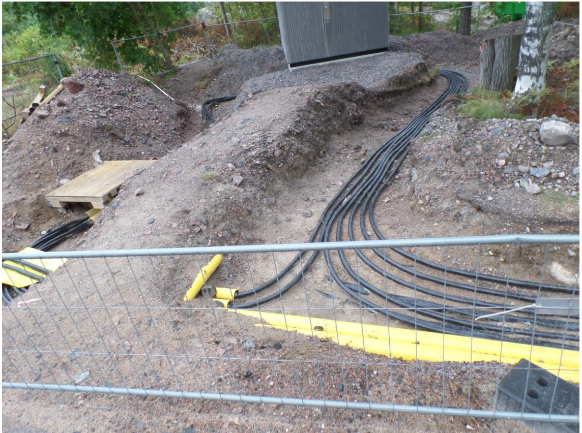
Kuva 10. Uudet kj- ja pj -kaapelit
