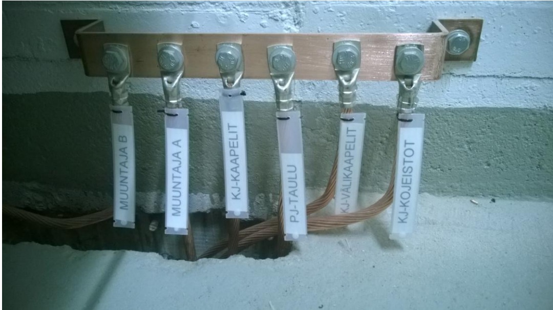
Kuva 19. Maadoituskisko ja siihen tuodut kuparit
