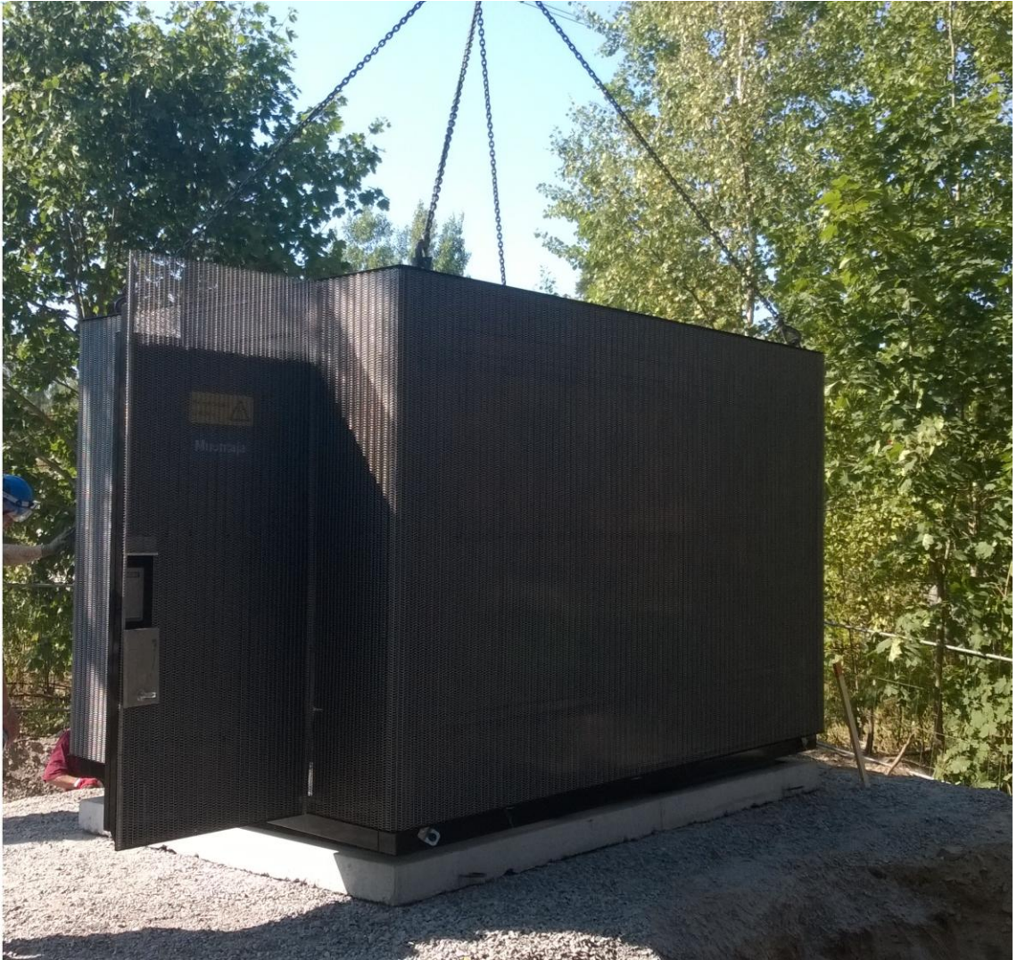
Kuva 4. Muuntamokopin nostaminen paikoilleen
