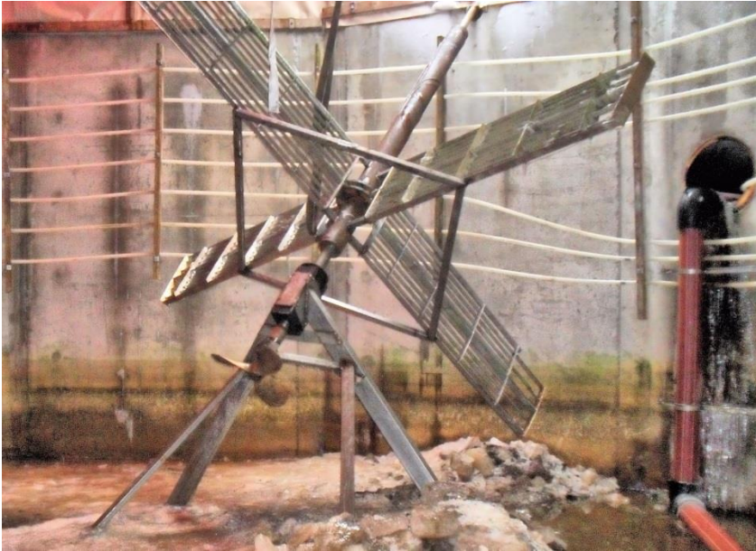
KUVIO 17. Sekoitin, syötteen tulo- ja poistoputki sekä lämmitysputket. (Kuva: Erkki Penttilä)
