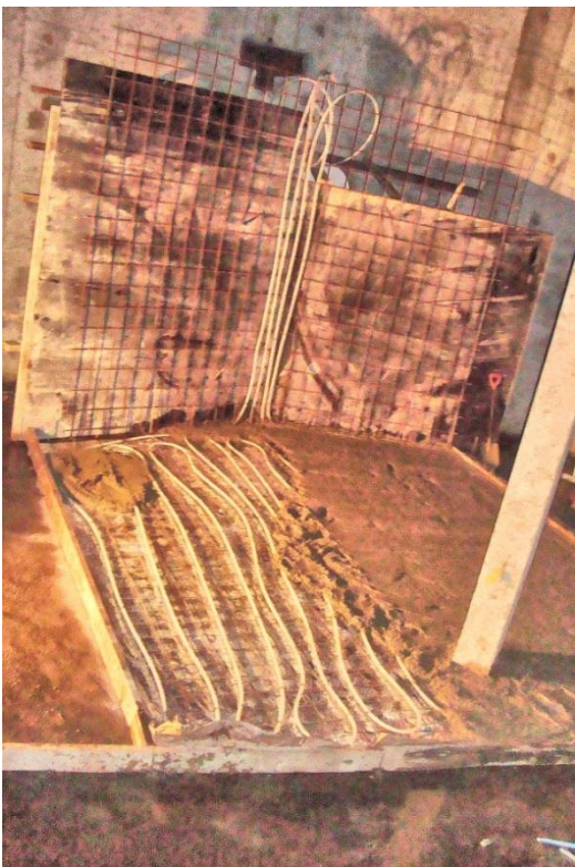
KUVIO 18. Lämmitysputkiston valu pohjalle ja pystyseinämään. (Kuva: Erkki Penttilä)
